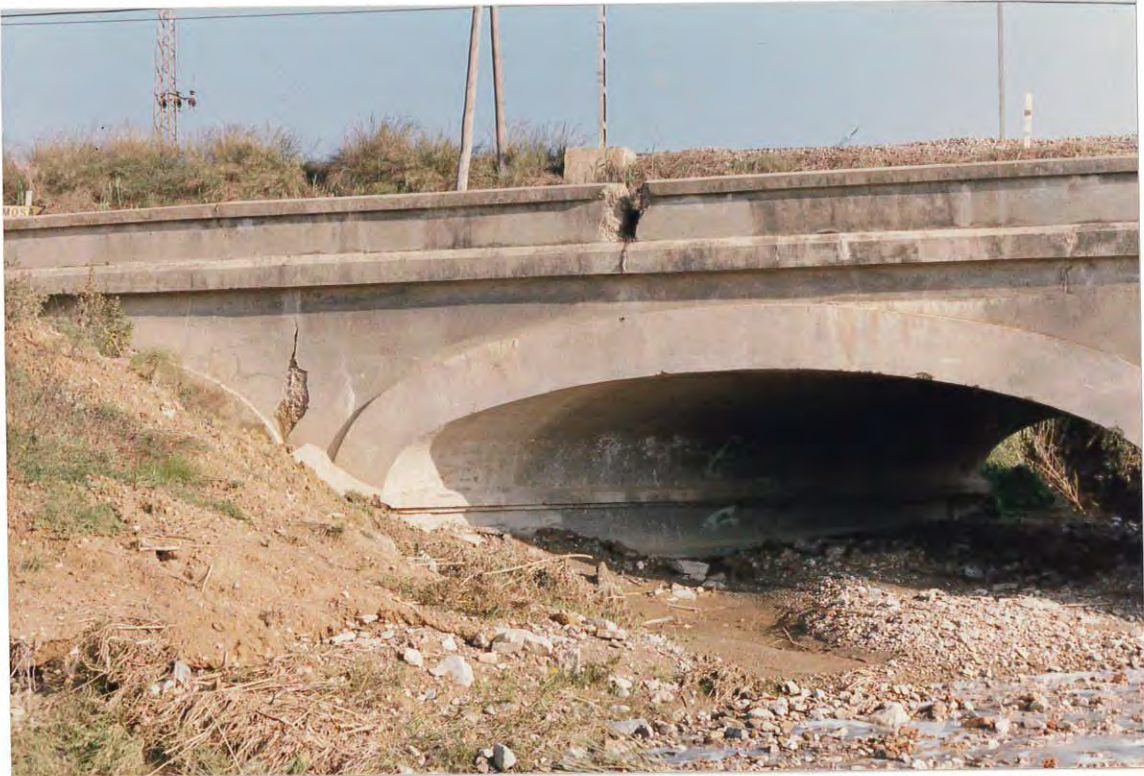
Figura 7. Taponamiento del vano derecho del puente de la carretera a Caldes de Montbui, visto desde aguas abajo.
