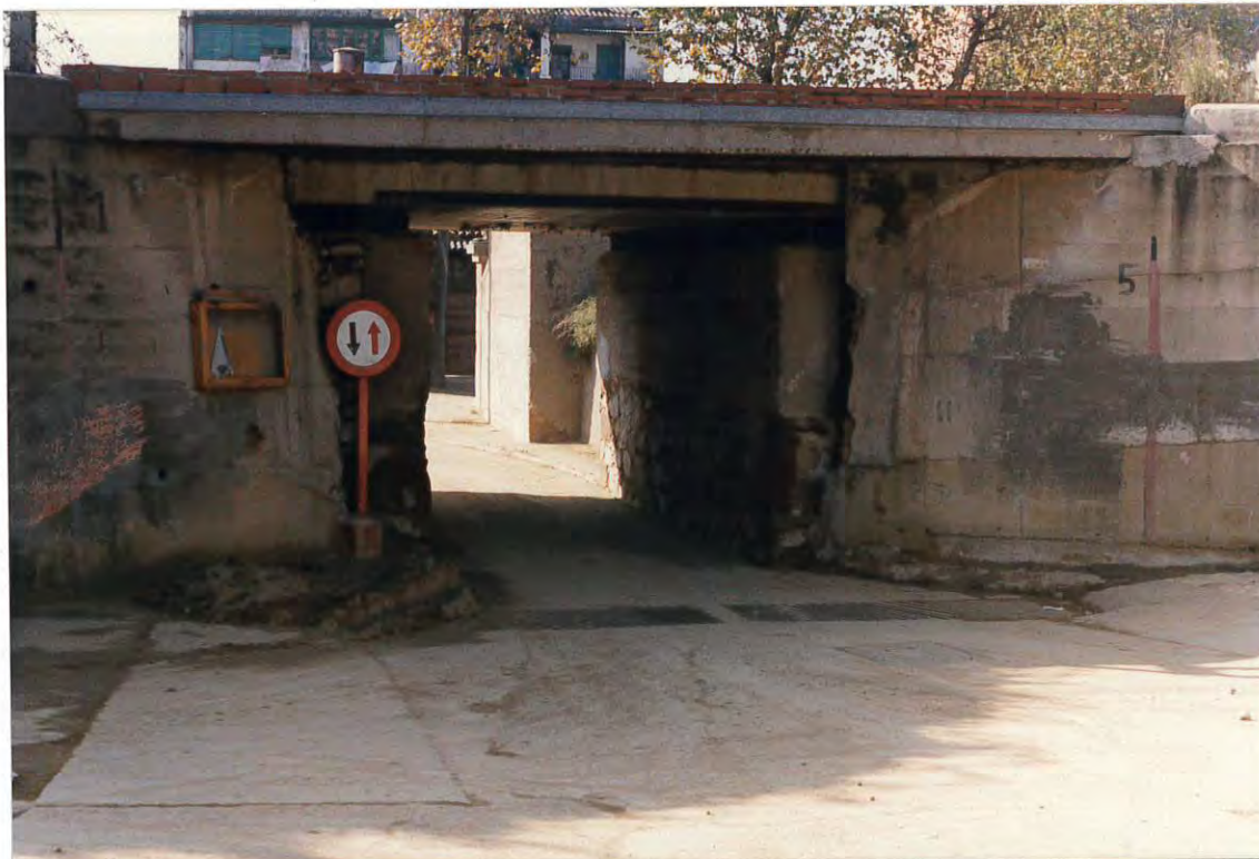
Figura 1. La riera Mariona a su paso bajo el puente del ferrocarril.
