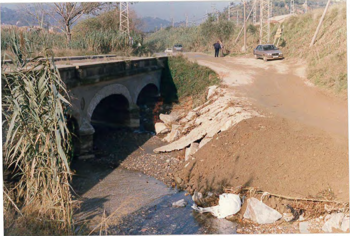
Figura 3. El puente de la carretera de Caldes de Montbui a Molins de Rei sobre la riera de Vallvidrera.
