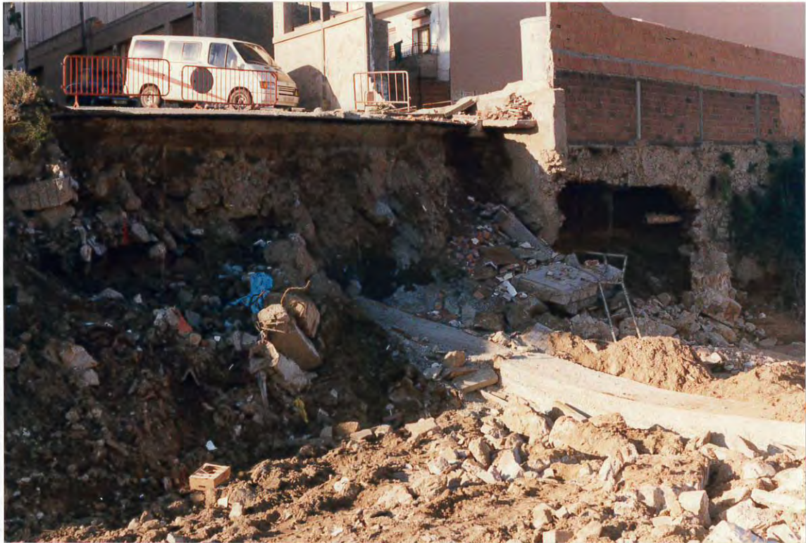
Figura 3. Erosión del margen derecho de la riera de Canyonó provocado por la gran velocidad del agua.
