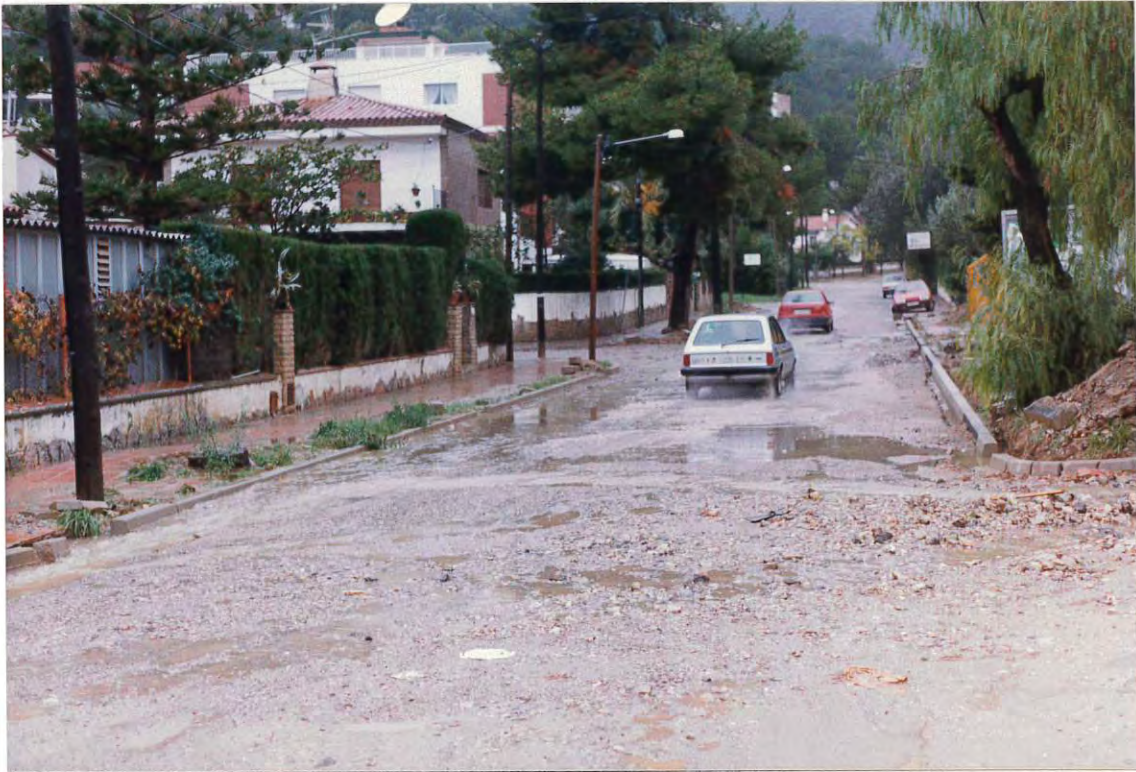
Figura 1. Arrastres acumulados en la avenida de Bellamar, aguas arriba de la carretera C-246 Autovía de Castelldefels.
