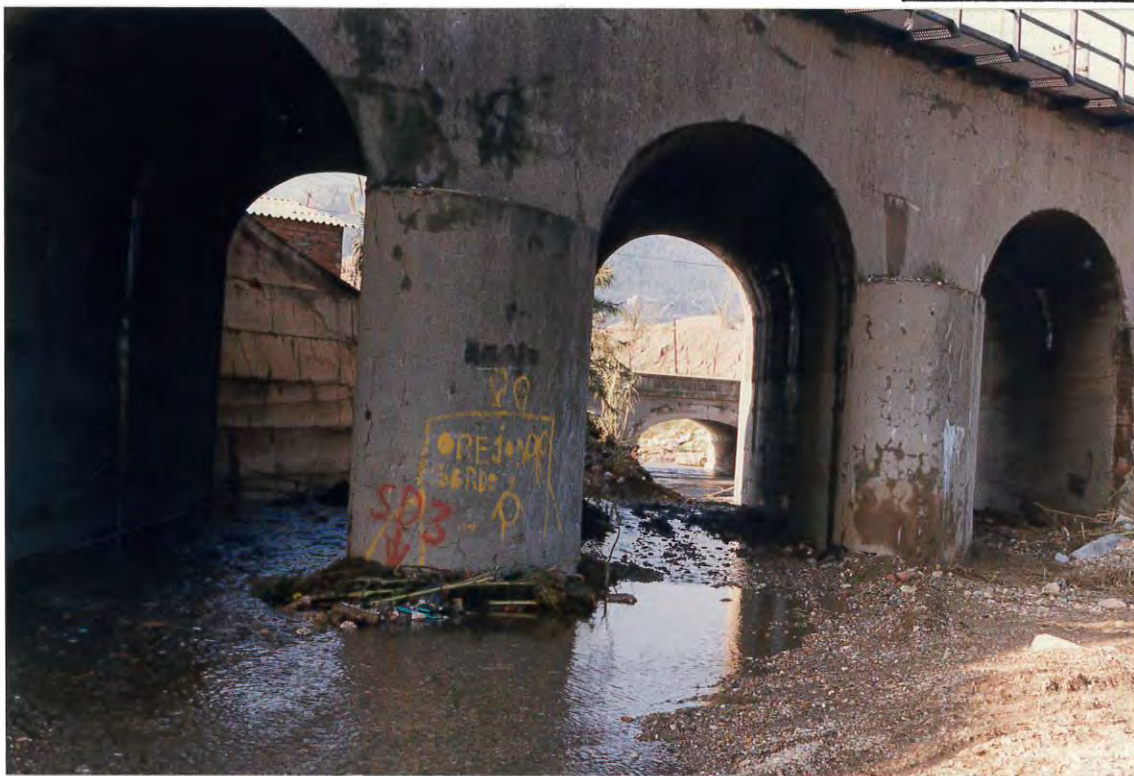
Figura 1. La riera de Vallvidrera a su paso bajo el puente del ferrocarril.
