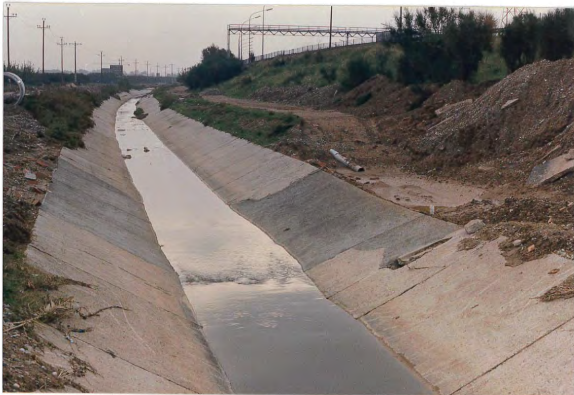
Figura 2. Reparaciones efectuadas en los hastiales del canal de desagüe.
