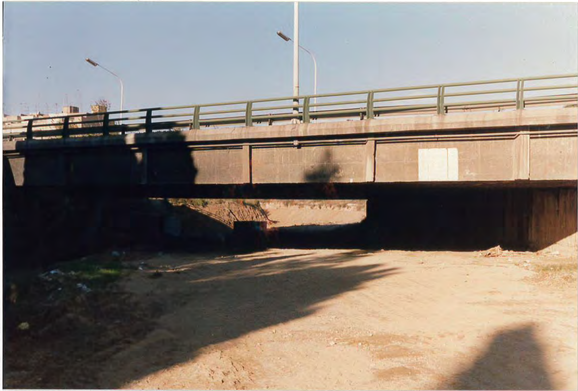
Figura 7. Paso de la riera de Canyadó bajo la autopista A-19.
