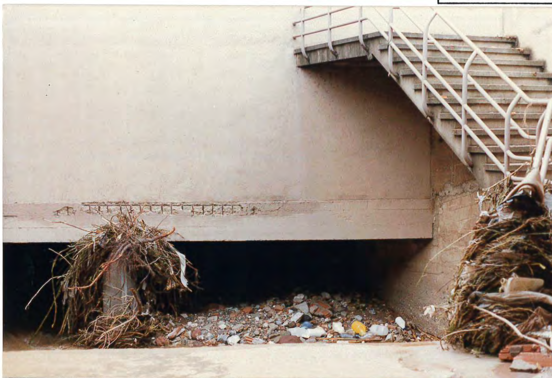
Figura 3. Arrastres acumulados a la entrada de la riera bajo la factoría Roca.
