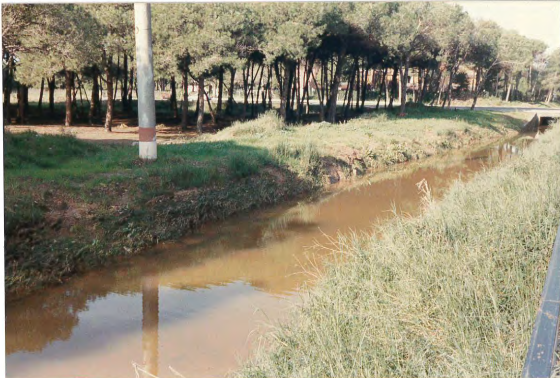
Figura 4. Riera dels Canyars, aguas abajo de la Autovía. El agua no llegó a superar la altura mínima de los márgenes.
