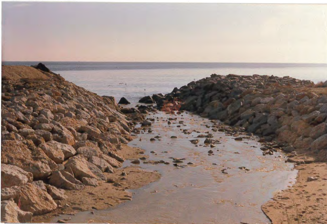
Figura 4. El caudal continuo de agua evita que la arena se acumule.
