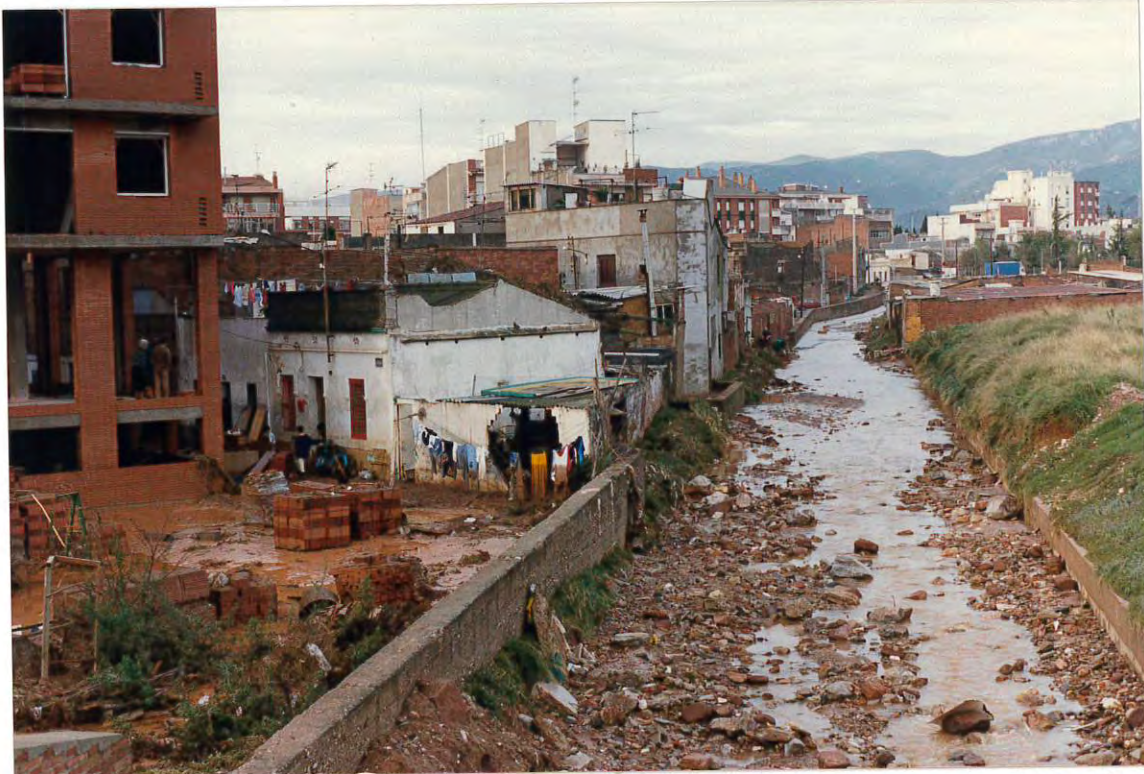
Figura 1. Vista de la riera aguas arriba de la carretera C-245. El nivel alcanzado por el agua quedó marcado en la ropa tendida en la parte izquierda de la fotografía.
