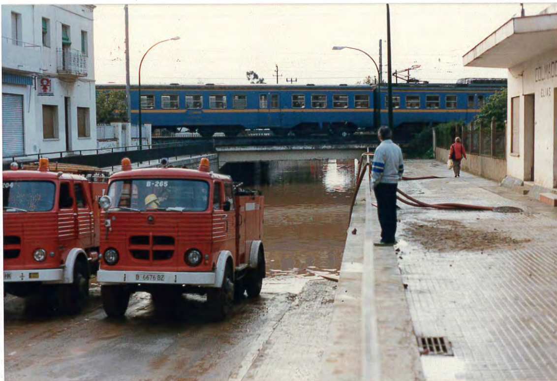
Figura 1. Puente de la Avenida de la Pineda bajo el ferrocarril Barcelona-Zaragoza, al día 13 de noviembre de 1988.
