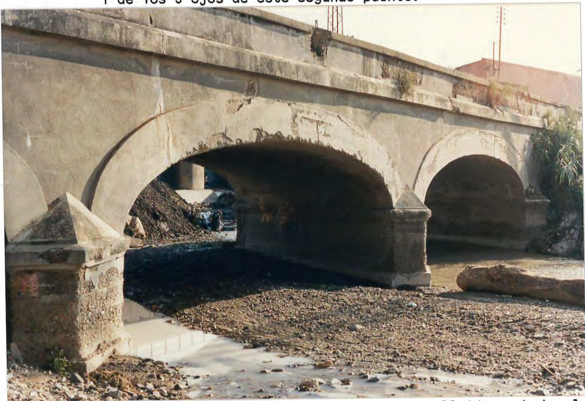
Figura 6. Arrastres acumulados en la riera de Vallvidrera bajo el puente de la carretera a Caldes de Montbui.
