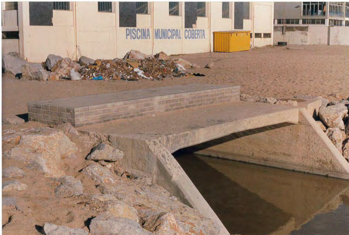
Figura 3. Desembocadura de la riera de Canyet. Al fondo, escombros y arrastres extraídos de la riera.
