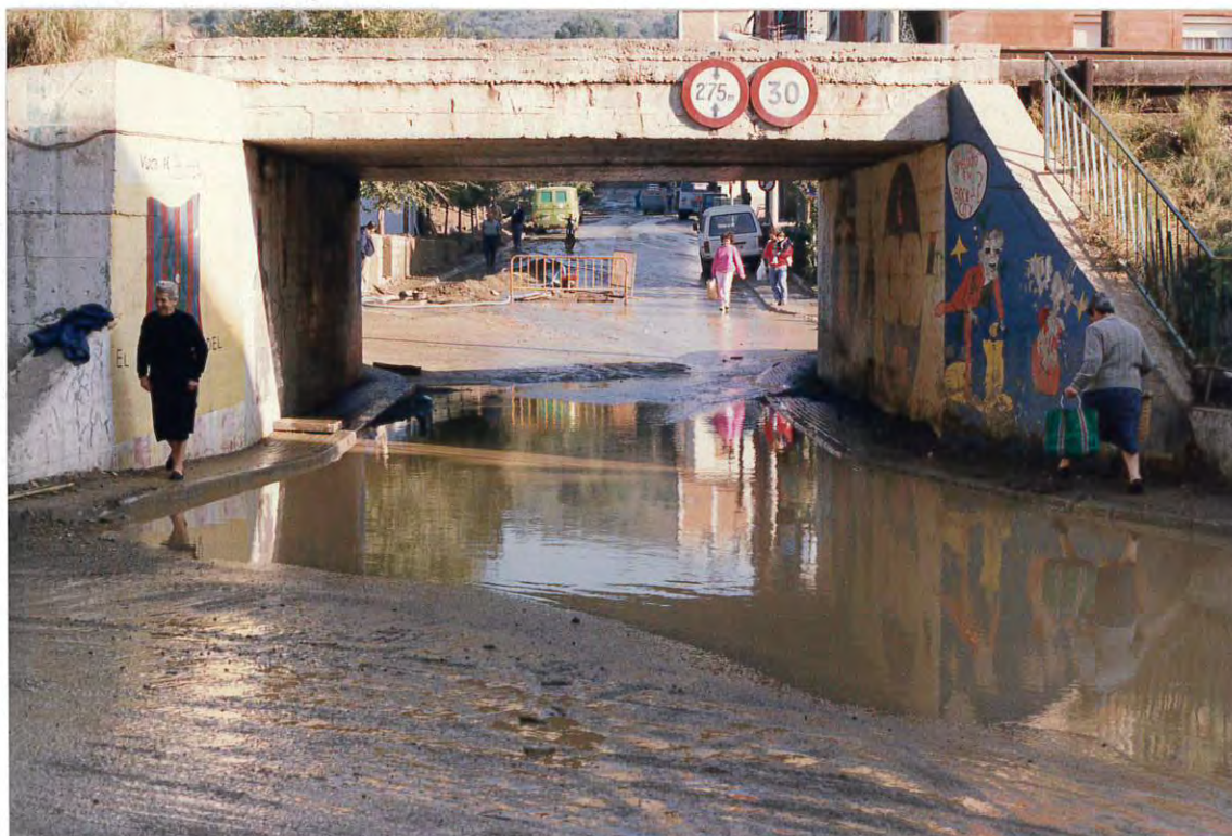
Figura 6. Puente del ferrocarril, cuyo gálibo quedo prácticamente cubierto por arrastres. Obsérvese los arrastres acumulados en la barandilla.
