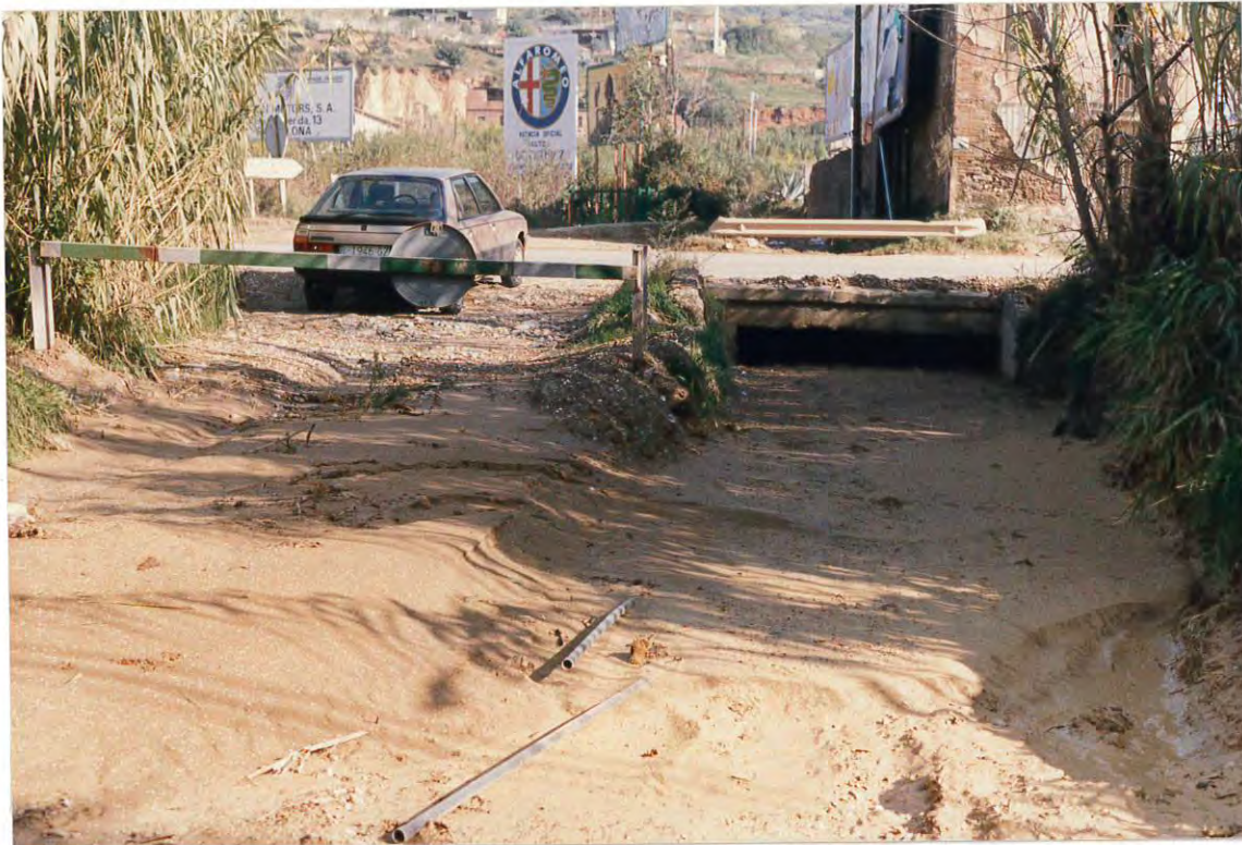
Figura 5. Riera de Can Sant Tomàs a su paso bajo la carretera N-II visto desde aguas abajo.
