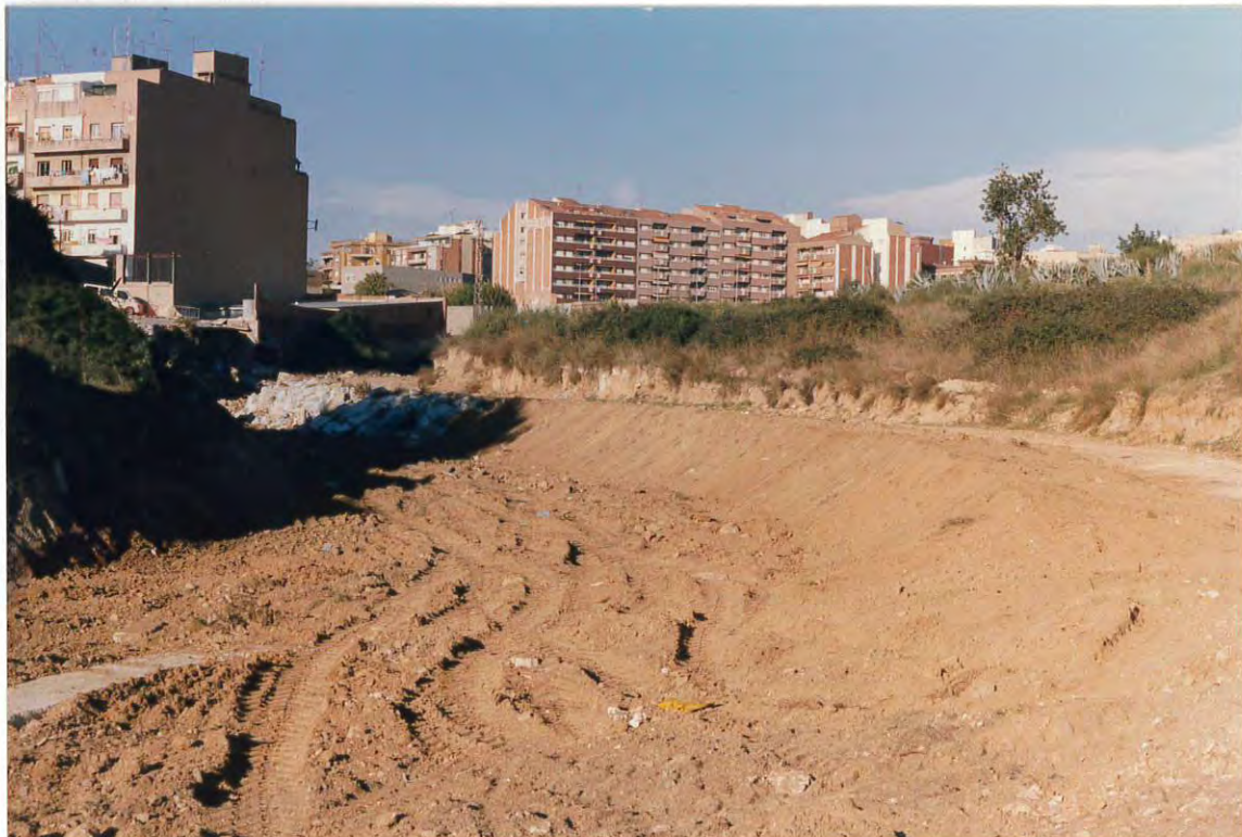
Figura 4. Reconstitución del cauce de la riera de Canyonó. El camino lateral había desaparecido parcialmente.
