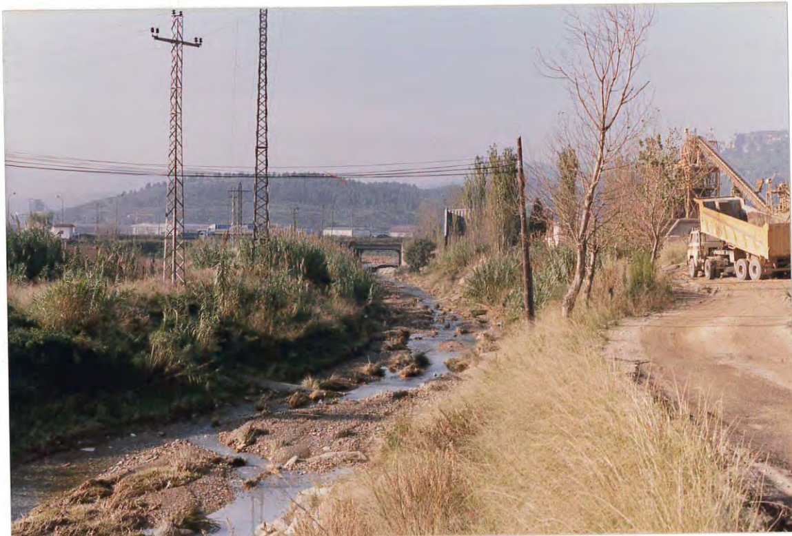
Figura 8. Riera de Vallvidrera aguas abajo de la carretera a Caldes de Montbui. Se aprecia una nueva reducción de la sección a su paso bajo la autopista A-2.
