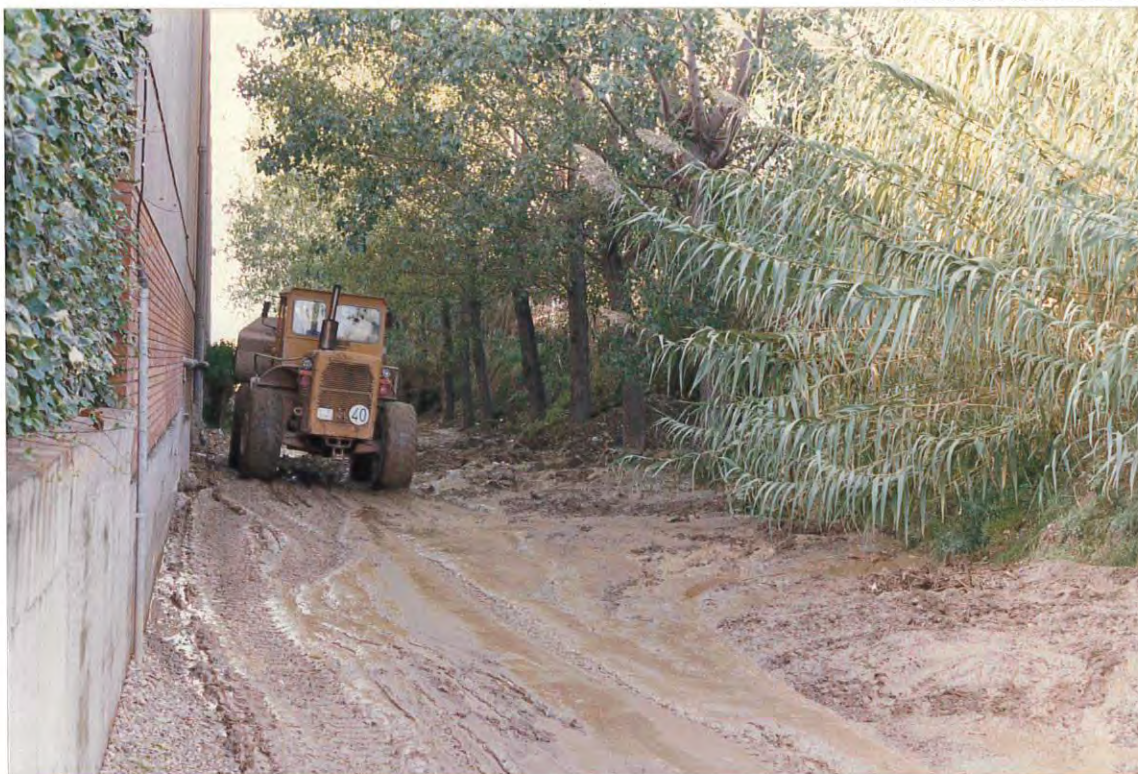
Figura 11. Trabajos de reconstrucción del cauce, donde puede apreciarse como el cauce discurre a una cota superior a la de la calle.
