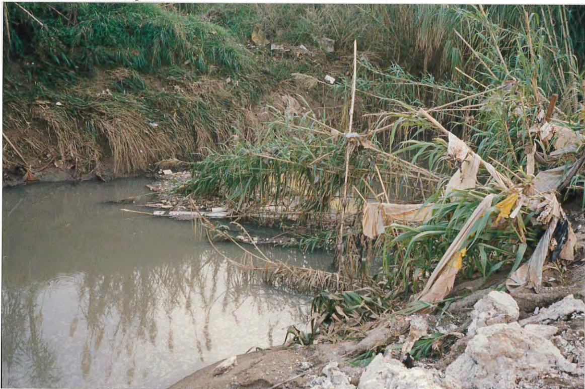
Figura 8. Salida de la riera de Sant Llorenç de su paso bajo la factoría Roca Radiadores.
