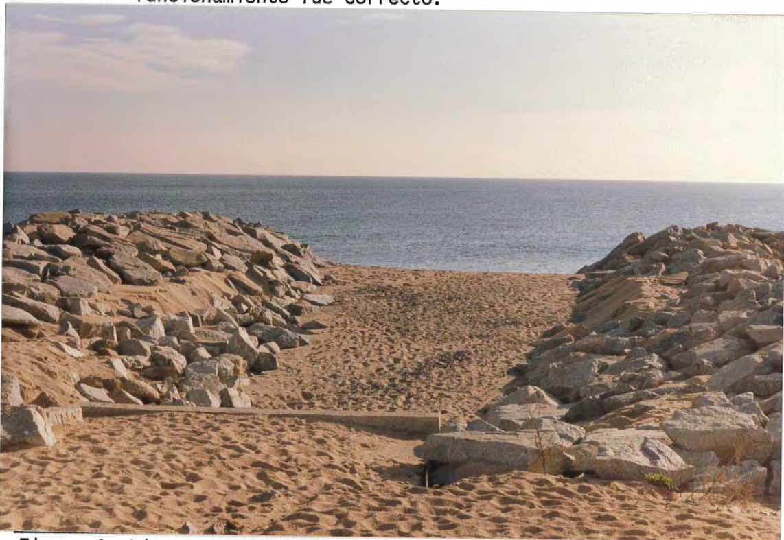
Figura 2. Ligera contrapendiente producida por la arena.
