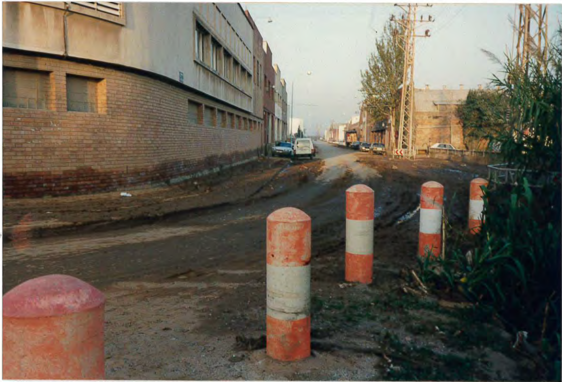
Figura 7. Final de la calle Agricultura, donde reaparece la riera de Sant Llorenç, con la marca del nivel máximo alcanzado por el agua.
