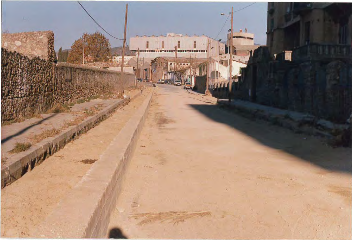
Figura 9. El agua ocupó toda la calle, superando los 70 cm de altura, debido a la progresiva reducción de la sección.
