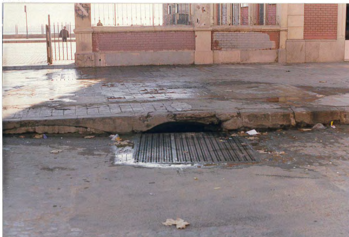
Figura 2. Reja encargada de recoger el agua que discurre por la riera de Canyet, antes de la estación de RENFE.
