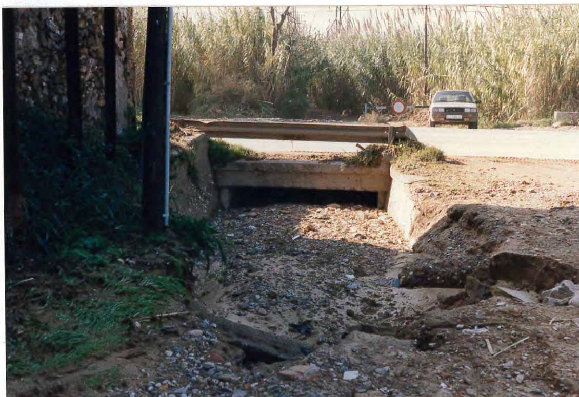
Figura 4. Arrastres acumulados en el paso inferior de la Riera de Can Sant Tomàs bajo la carretera N-II, visto desde aguas arriba.
