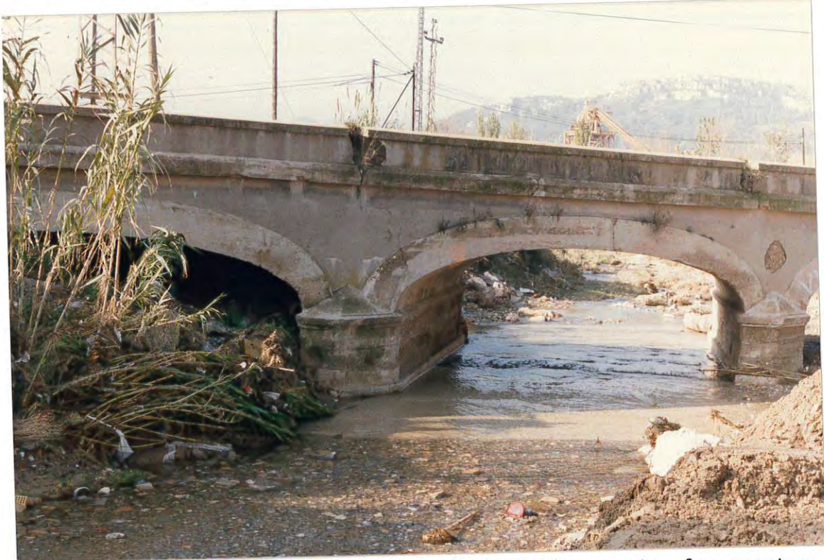
Figura 5. La sección de la riera de Vallvidrera entre los puentes del ferrocarril y de la carretera es prácticamente igual a 1 de los 5 ojos de este segundo puente.
