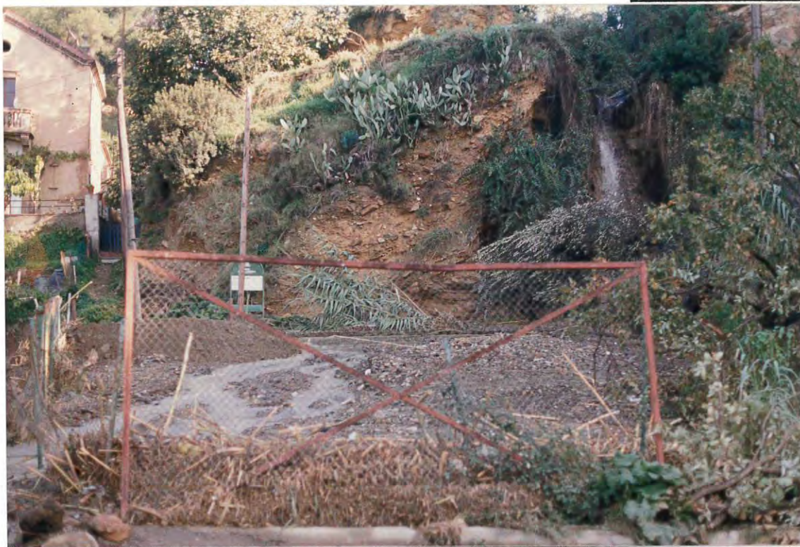
Figura 1. La cascada del Torrent d'en Benet, antes de su entrada en el casco urbano, y el dispositivo de retención de arrastres que quedó totalmente aterrado.
