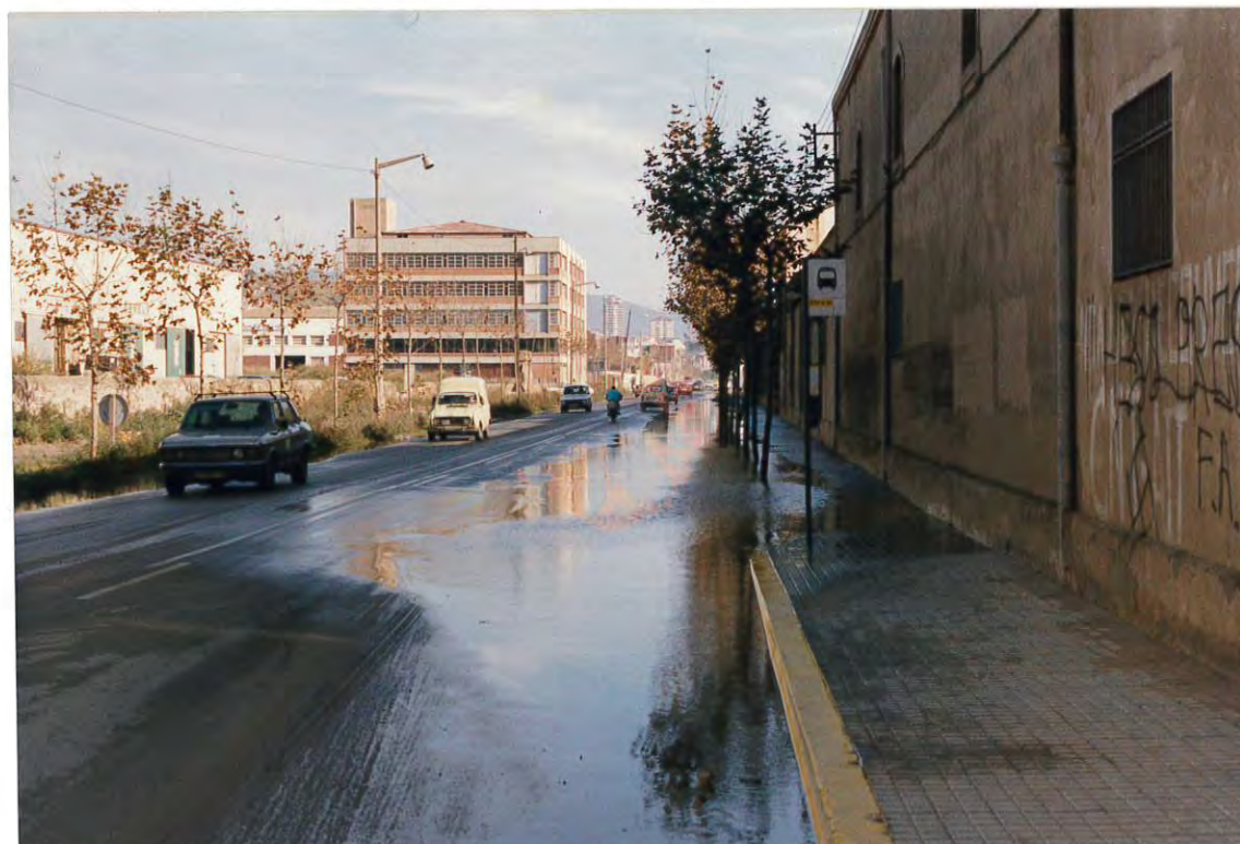
Figura 12. La falta de desagües y el desbordamiento de la Riera Canyadó provocaron la acumulación de agua en la carretera nacional N-II.
