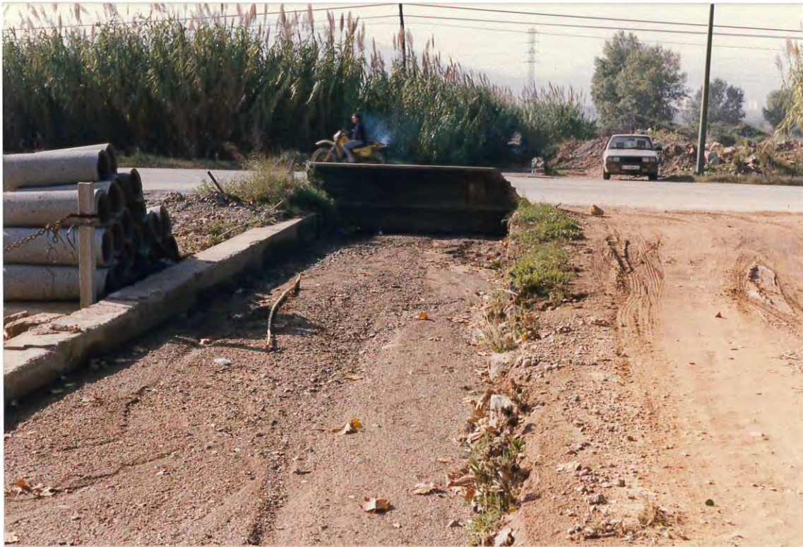
Figura 1. Cauce de la riera Can Paissa a su paso bajo la carretera nacional N-II, visto desde aguas arriba.
