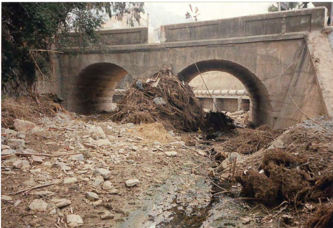
Figura 2. Otro puente del núcleo urbano, visto desde aguas arriba, donde puede observarse la altura alcanzada por los arrastres y los escombros acumulados en el cauce.
