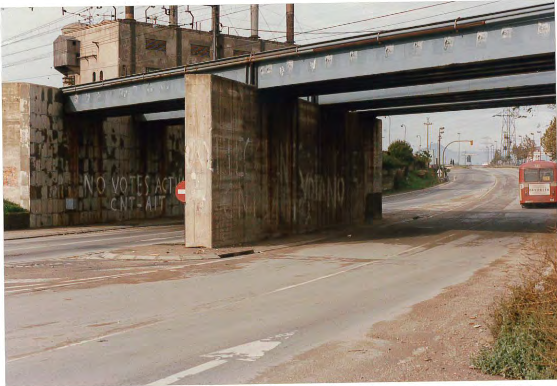
Figura 9. Acceso a El Prat de Llobregat bajo el puente de la línea férrea. Las inundaciones fueron menores que en el otro paso inferior debido a su cota relativamente superior.
