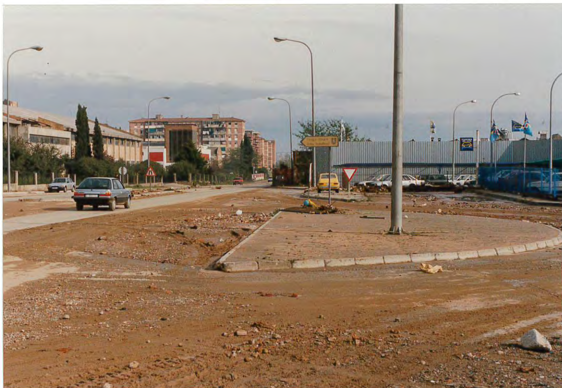
Figura 1. Cruce de la riera con la carretera C-245, donde pueden observarse la gran cantidad de arrastres acumulados.
