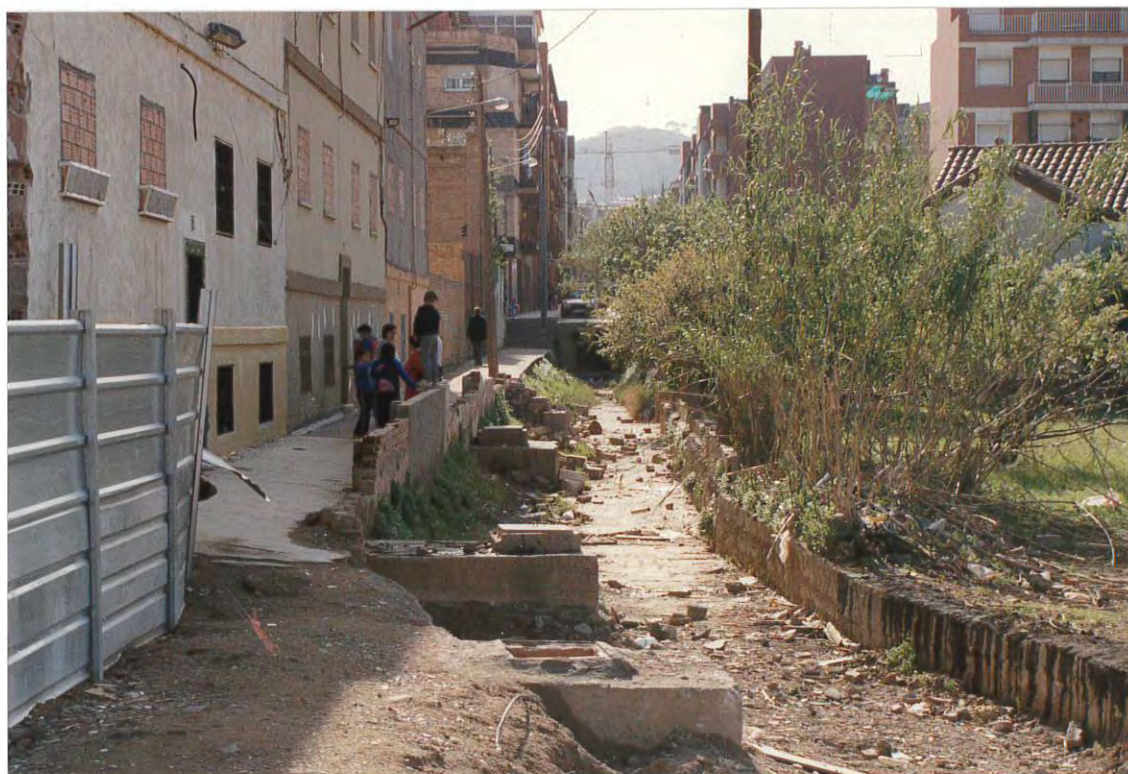
Figura 4. Cauce antiguo de la riera Guinovart por el que sigue circulando gran cantidad de agua en caso de lluvias de moderada intensidad.
