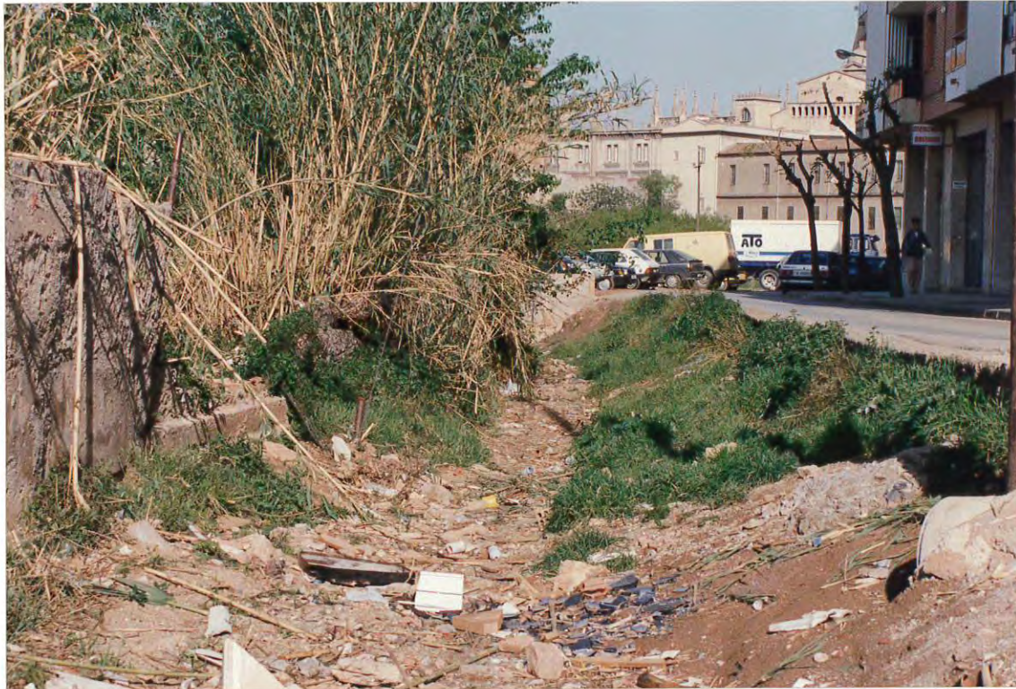
Figura 5. Cauce antiguo de la riera Guinovart, aguas abajo del edificio derrumbado, donde puede observarse la acumulación de arrastres y la tubería de vertido en la margen derecha.
