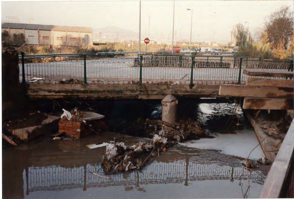
Figura 3. Puente de la carretera BV-2002 sobre la riera Bertràn.
