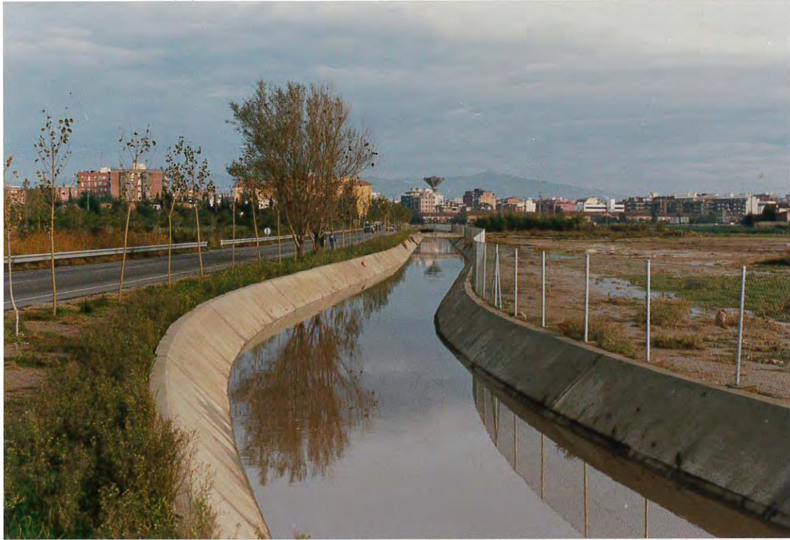
Figura 3. Canal de la Aviación. Su funcionamiento fue plenamente satisfactorio.
