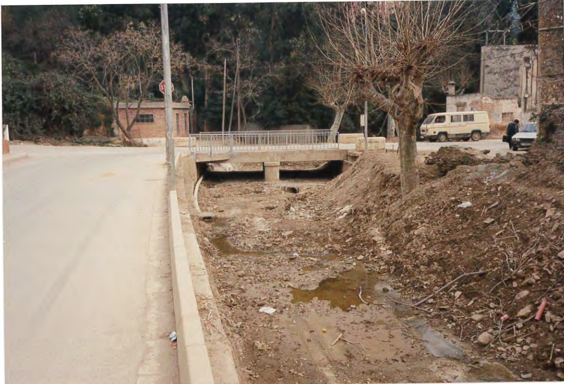
Figura 1. Primer puente de la riera en el núcleo urbano de Sant Climent, donde puede observarse su escasa altura, el muro caído a la derecha y un tramo de barandilla repuesto.
