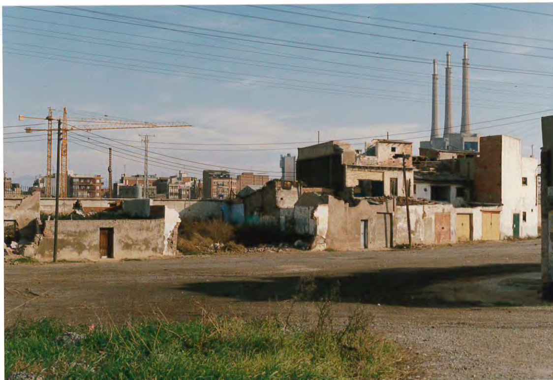
Figura 4. Derrumbamiento de varias casas causado por las inundaciones.
