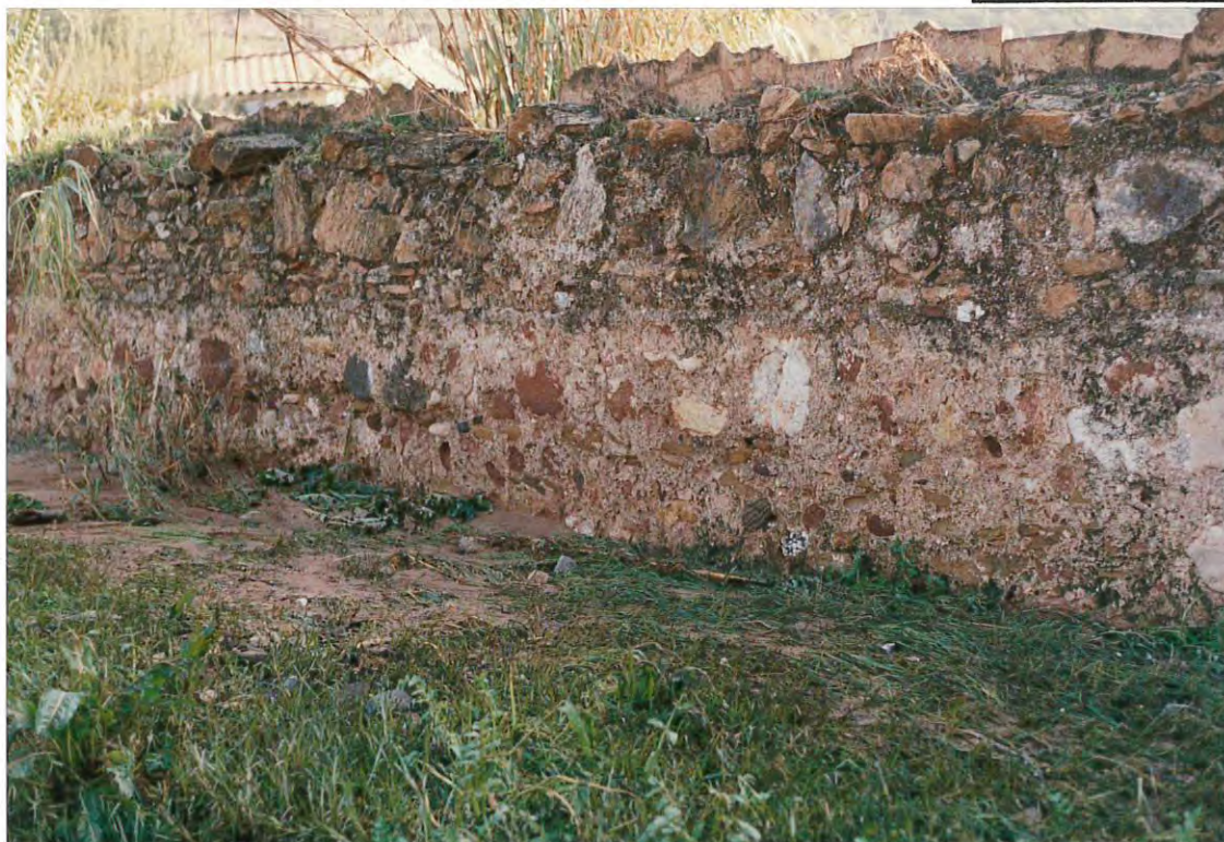
Figura 5. Altura alcanzada por el agua, aguas abajo del puente del ferrocarril.
