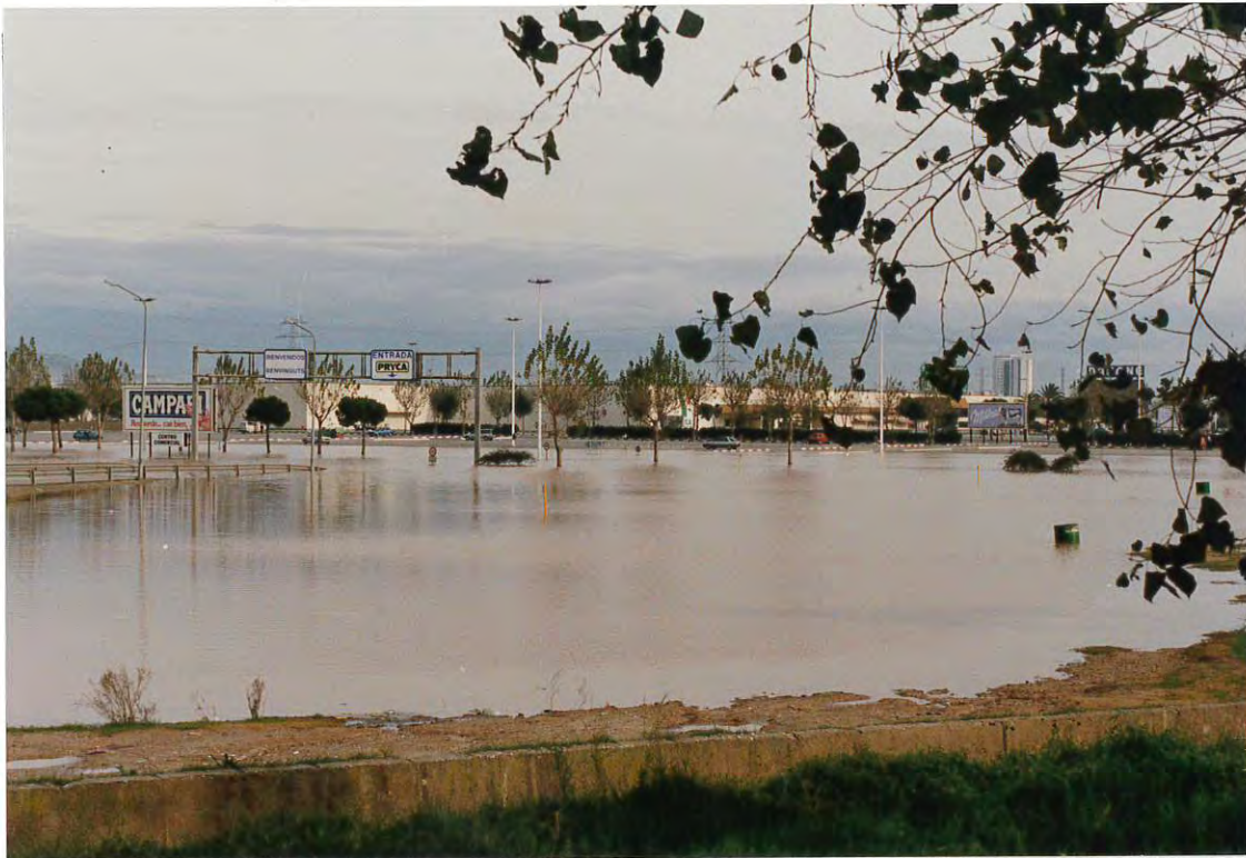
Figura 1. Aparcamiento de PRYCA, en la cabecera de la cuenca de la Aviación. El desagüe bajo la Autovía es claramente insuficiente.
