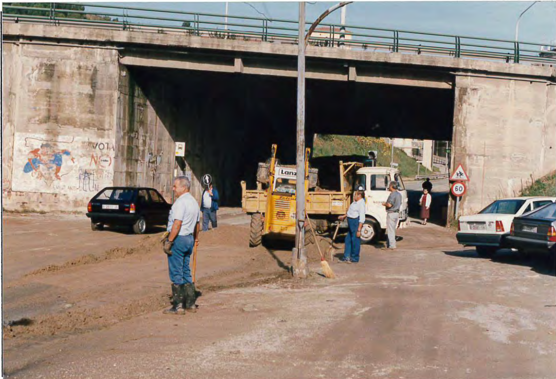
Figura 1. Trabajos de limpieza de los arrastres acumulados en el paso inferior de la carretera de Mongat a Tiana bajo la autopista A-19.
