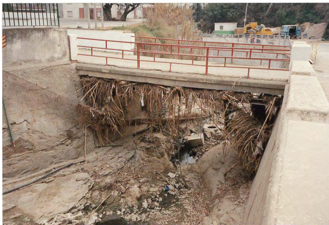
Figura 4. Ultimo puente del núcleo urbano, tras el cual puede observarse el muro construido y la maquinaria empleada en la reconstrucción de la carretera a Viladecans.
