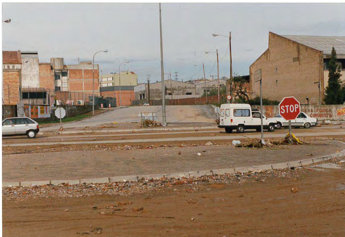
Figura 2. Vista de la riera aguas arriba de la carretera C-245, donde no existe ninguna reja interceptora a lo largo del tramo enterrado.
