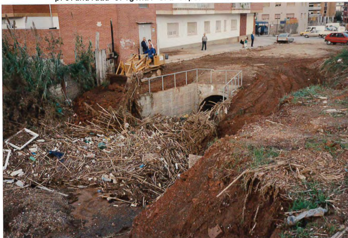
Figura 2. Detalle de los arrastres acumulados en la embocadura de la parte cubierta de riera Basté.
