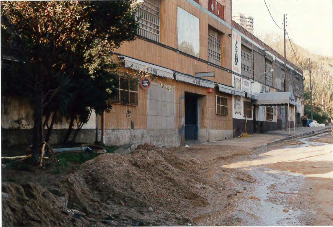
Figura 1. Arrastres acumulados en la riera d'en Font, antes de su paso bajo la carretera nacional N-II.
