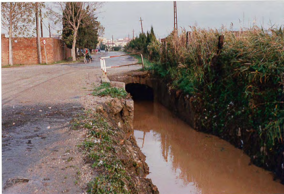
Figura 4. Fin del tramo remodelado de la cuenca de la Bunyola. Unicamente en este punto hubo un ligero desbordamiento de las aguas.
