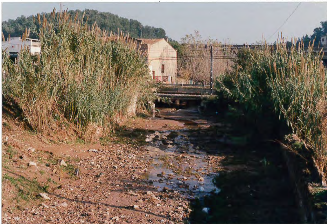
Figura 3. El Torrent Batsacs a su paso bajo el puente de RENFE. El buen estado del cauce evitó que los daños fueran mayores.
