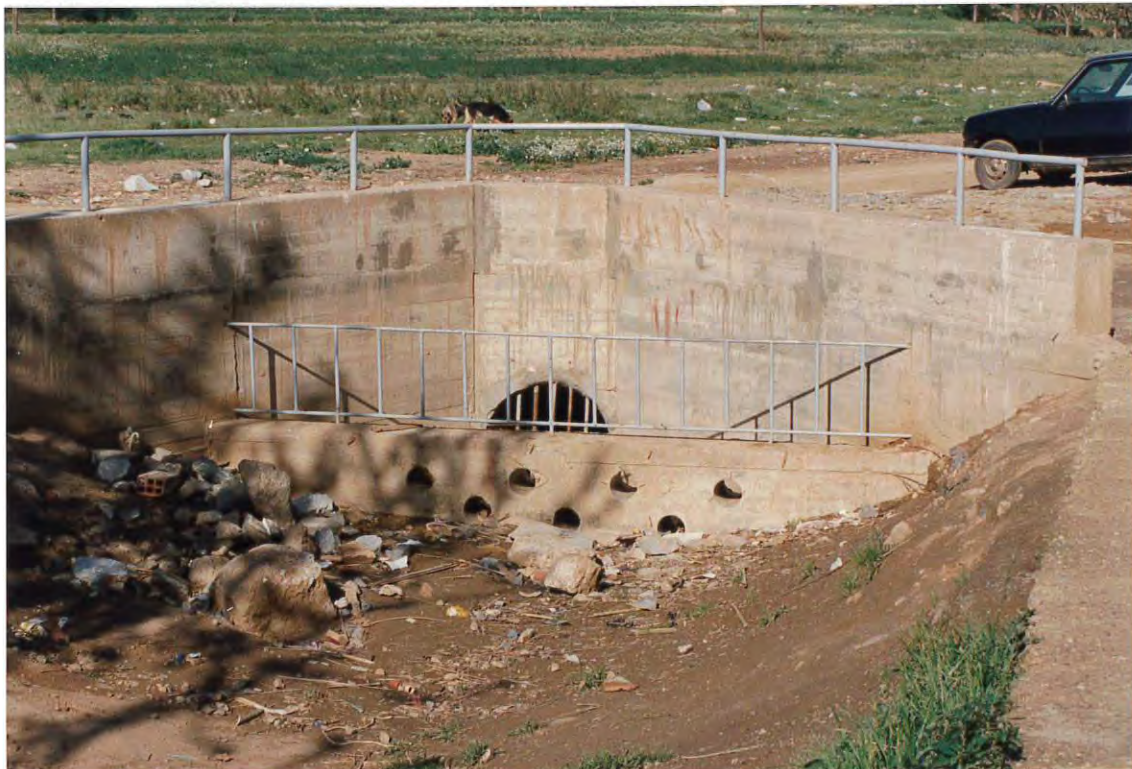
Figura 6. Dispositivo de retención de arrastres en la entrada de las aguas desde el cauce antiguo hacia el nuevo cauce en cajón, donde puede observarse el grado de colmatación.
