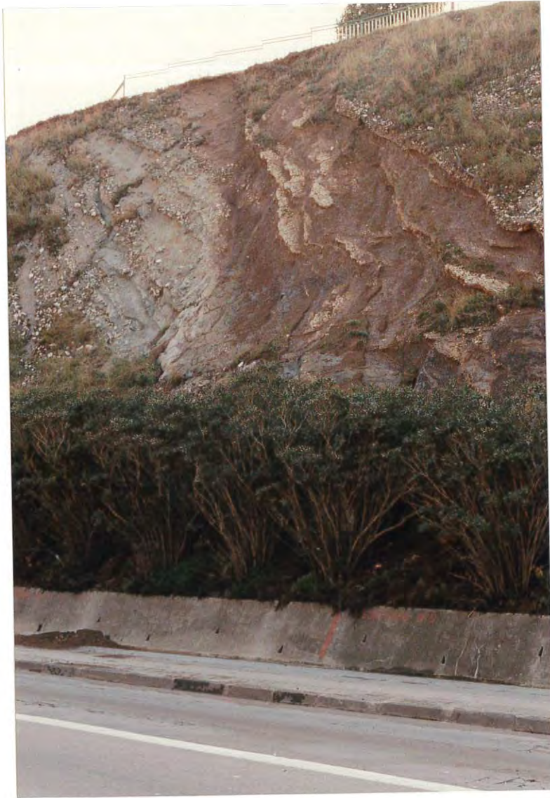
Figura 1. Turó del Mar, en el que se aprecia el hueco dejado por el desprendimiento que cortó la carretera nacional N-II, a la altura de Mongat.
