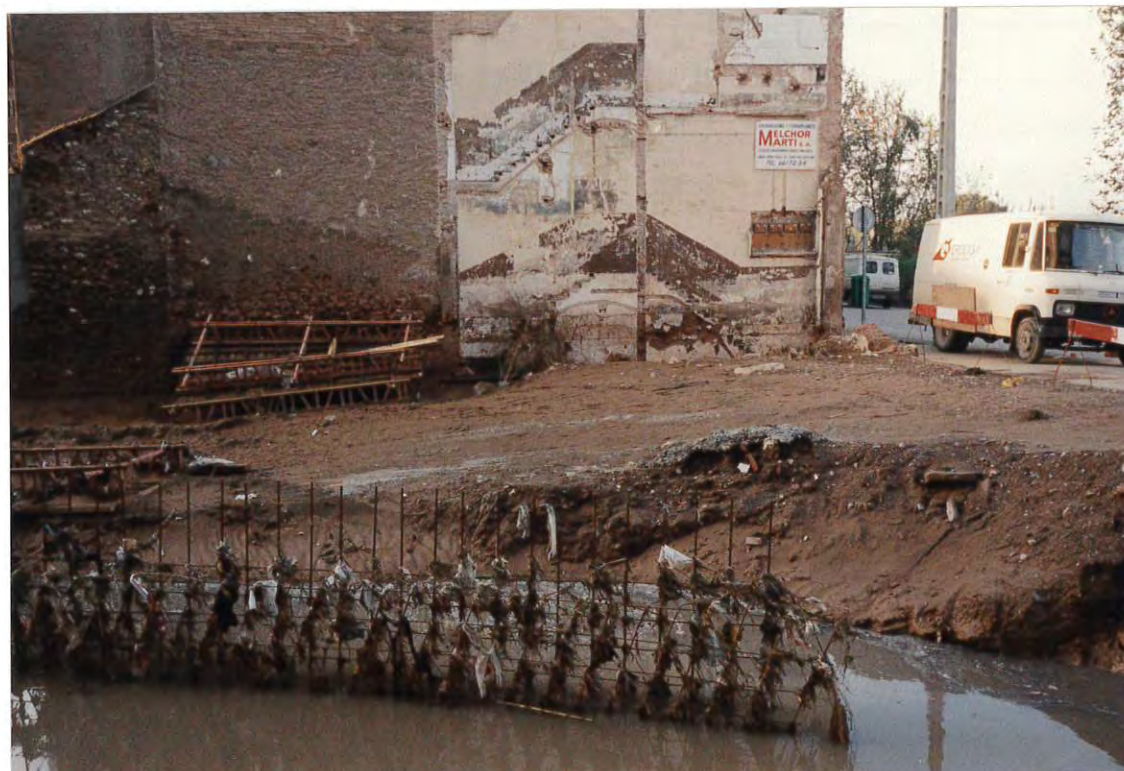
Figura 2. Nivel máximo alcanzado por las aguas en la riera Bertràn (obsérvese la pared blanca y la furgoneta).
