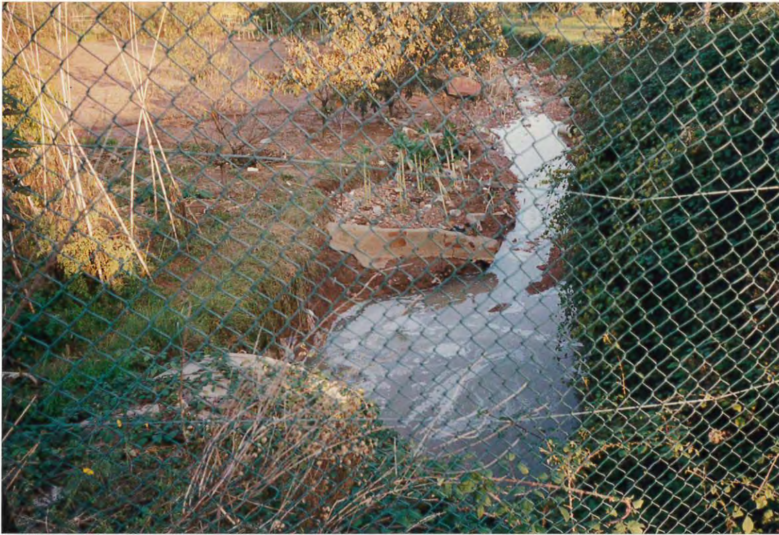
Figura 1. La riera Boter, aguas abajo del núcleo urbano, donde puede apreciarse la disminución de capacidad y el barro acumulado en el campo adyacente.
