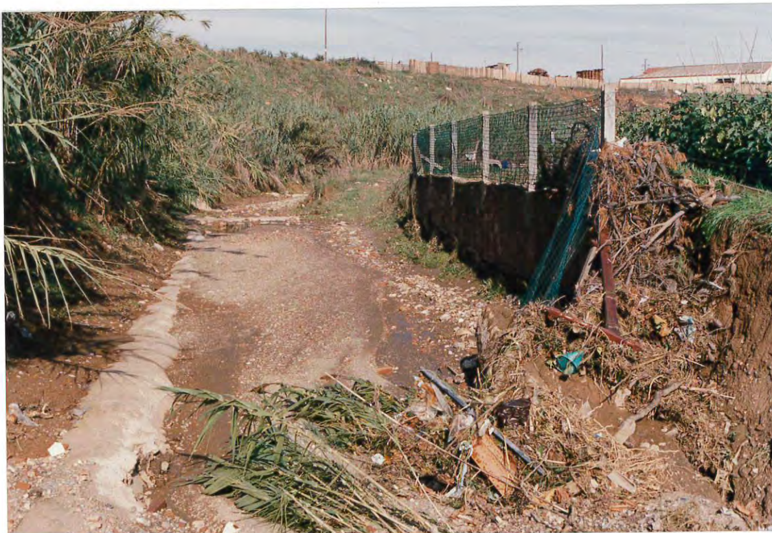
Figura 2. Cauce de la riera en la zona agrícola, donde el agua sobrepasó las protecciones laterales.
