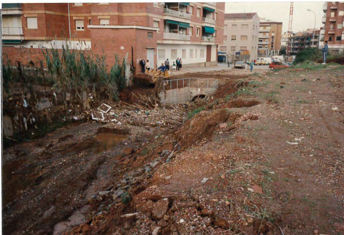
Figura 1. Riera Basté a su entrada en el núcleo urbano. El charco existente ocupa el lugar de un desarenador cuya profundidad original era superior a 3 m.
