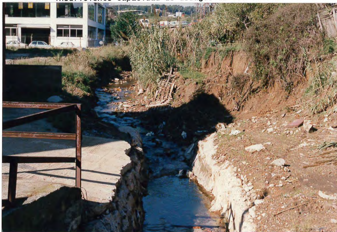
Figura 4. El Torrent Tapioles antes de su entrada al colector de 2 x 2 m.
