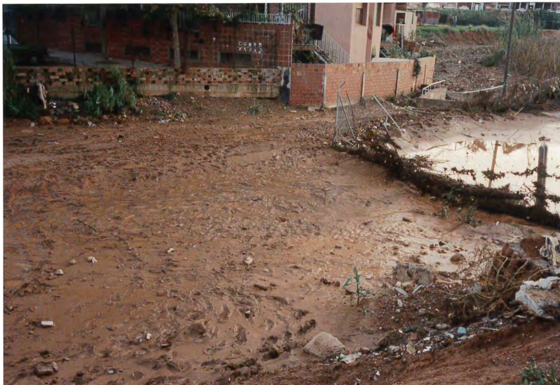
Figura 1. Embocadura de la riera Guinovart, en la que puede observarse el barro acumulado y la altura alcanzada por los arrastres atrapados en la verja.
