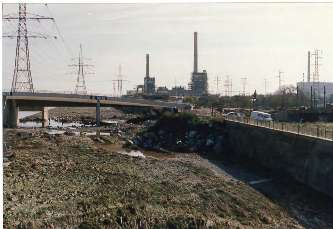
Figura 2. La sensible reducción del cauce, junto con el debilitamiento del hastial derecho, provocaron la inundación del barrio La Catalana.
