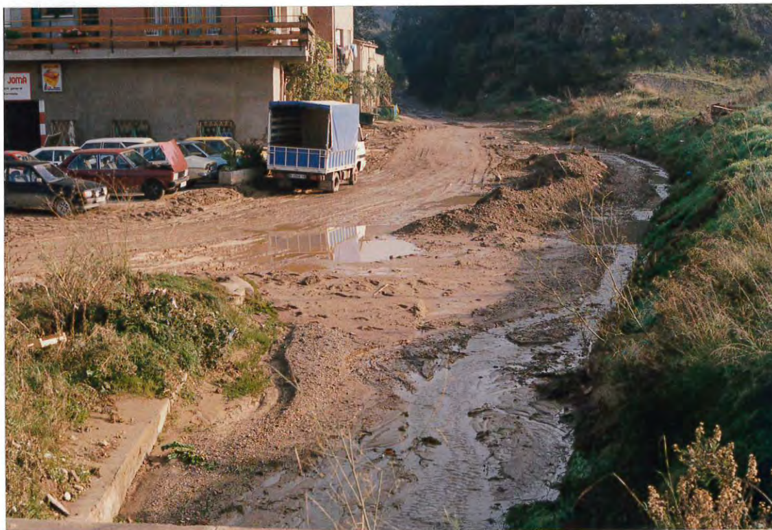
Figura 4. La riera de les Argiles, antes del tramo canalizado.
