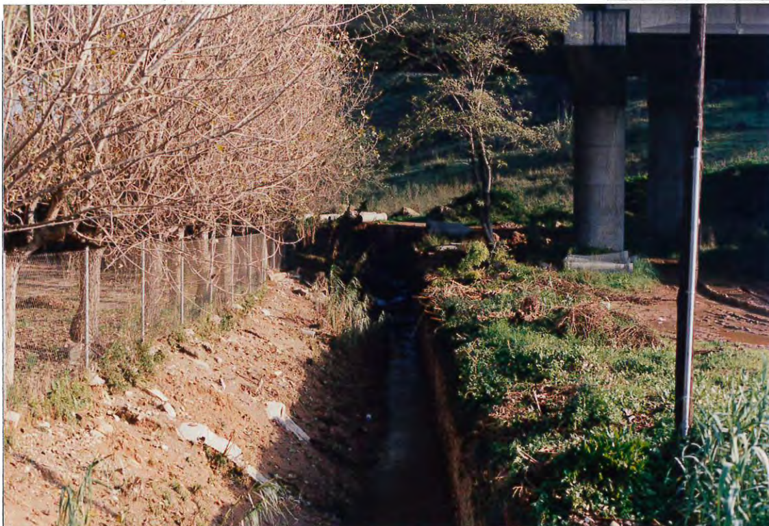
Figura 1. El Torrent Batsacs, bajo la autopista A-2.
