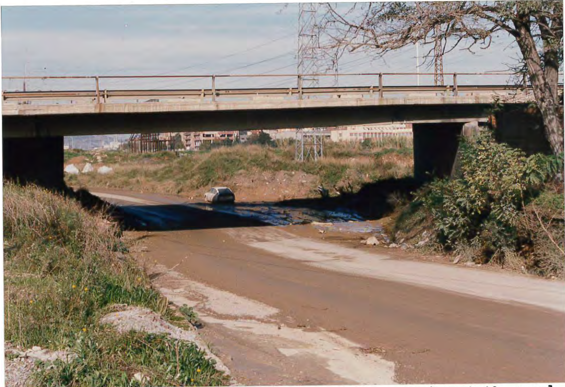
Figura 1. Calle Moratín bajo el puente de la autopista A-19, ramal dirección Barcelona, en la que puede apreciarse el desagüe totalmente cubierto por el barro.
