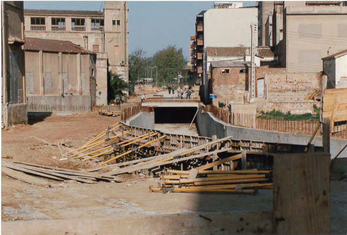
Figura 7. Construcción del nuevo cajón de encauzamiento en el punto de unión de las rieras Basté y Gasulla.
