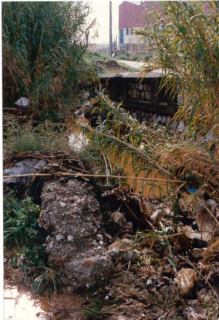
Figura 3. Riera del Fonollar, aguas abajo de la carretera C-245.
