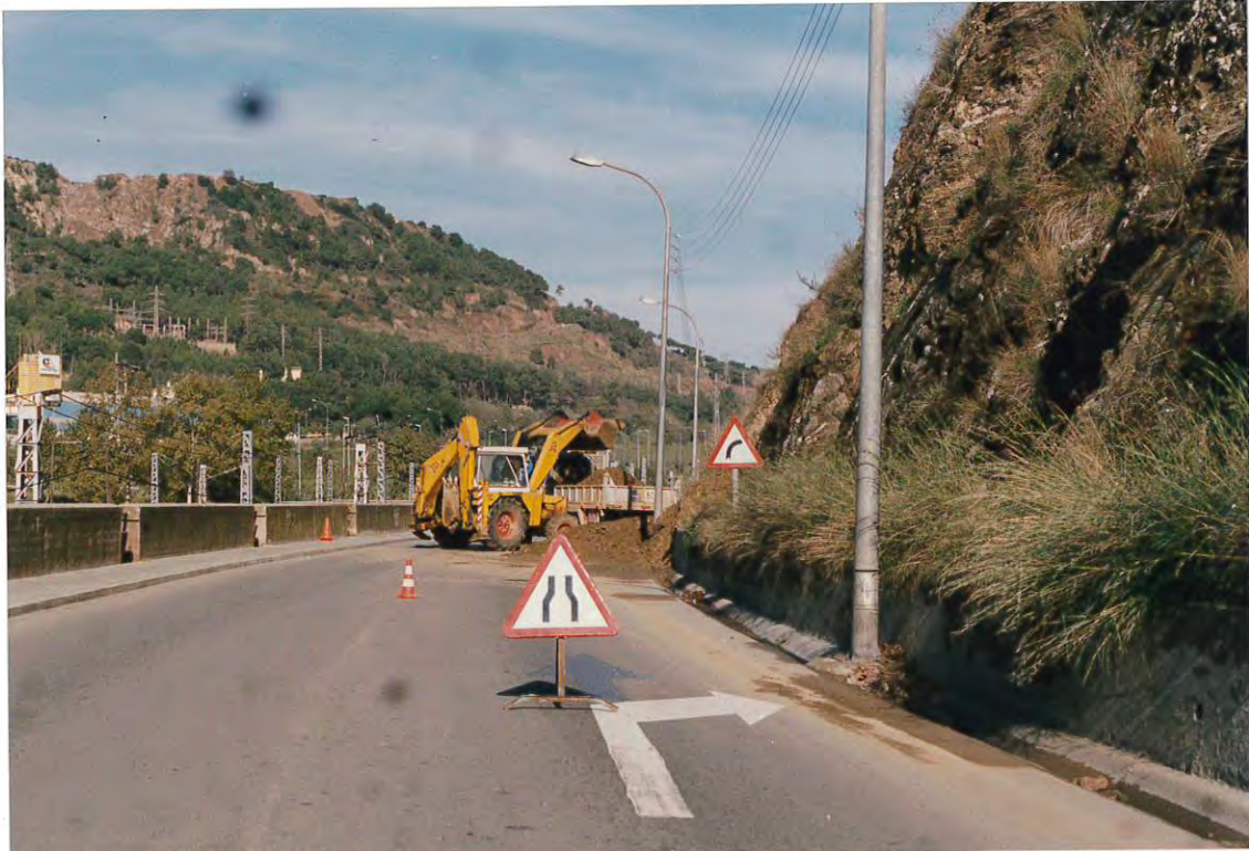
Figura 1. Trabajos de limpieza de los desprendimientos acumulados en la carretera de acceso a la barriada de Can Joan.
