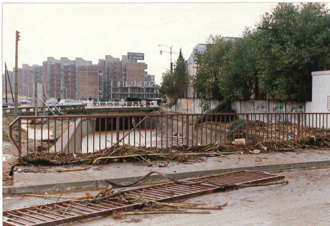
Figura 2. Desperfectos causados por la fuerza del agua en el mismo puente de la figura anterior.
