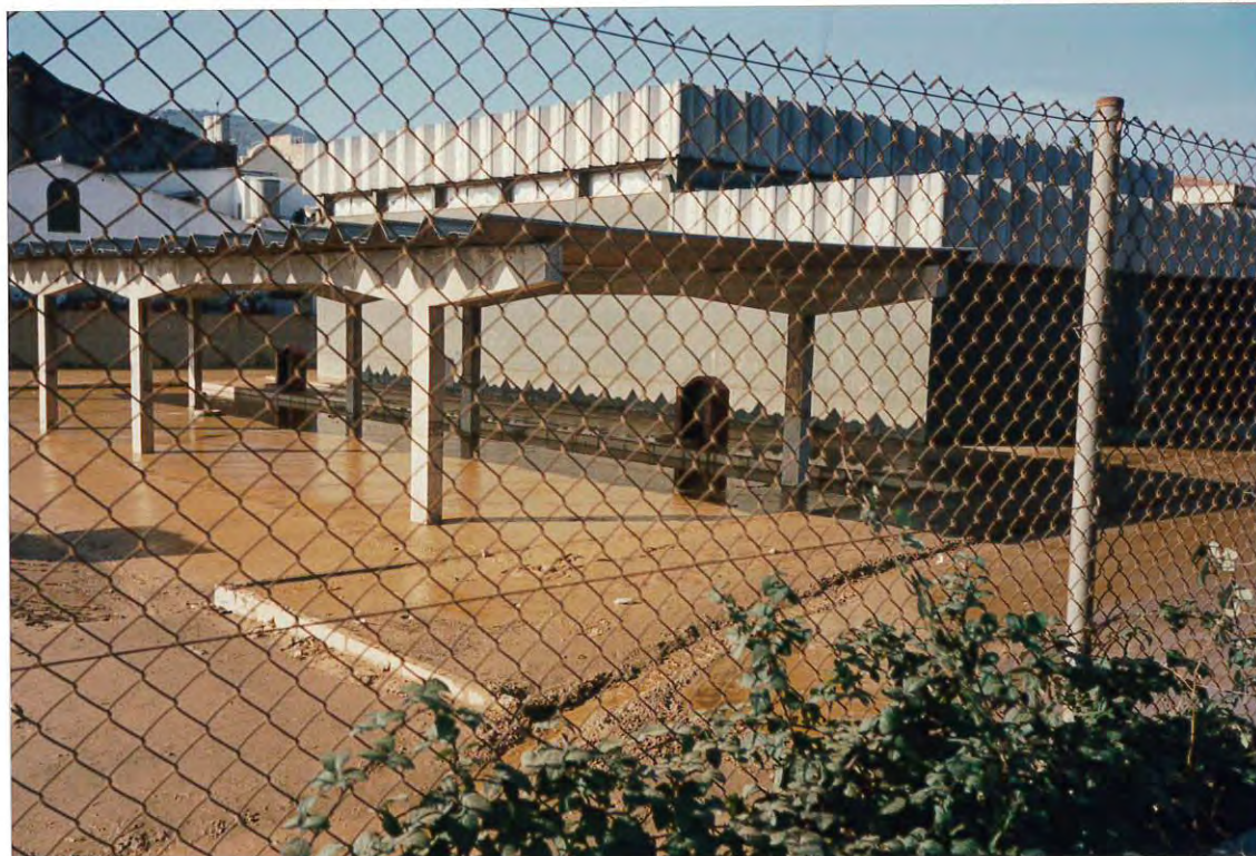
Figura 3. Otra vista del mismo colegio, con la señal dejada por el nivel máximo de agua a 60 cm en la pared.
