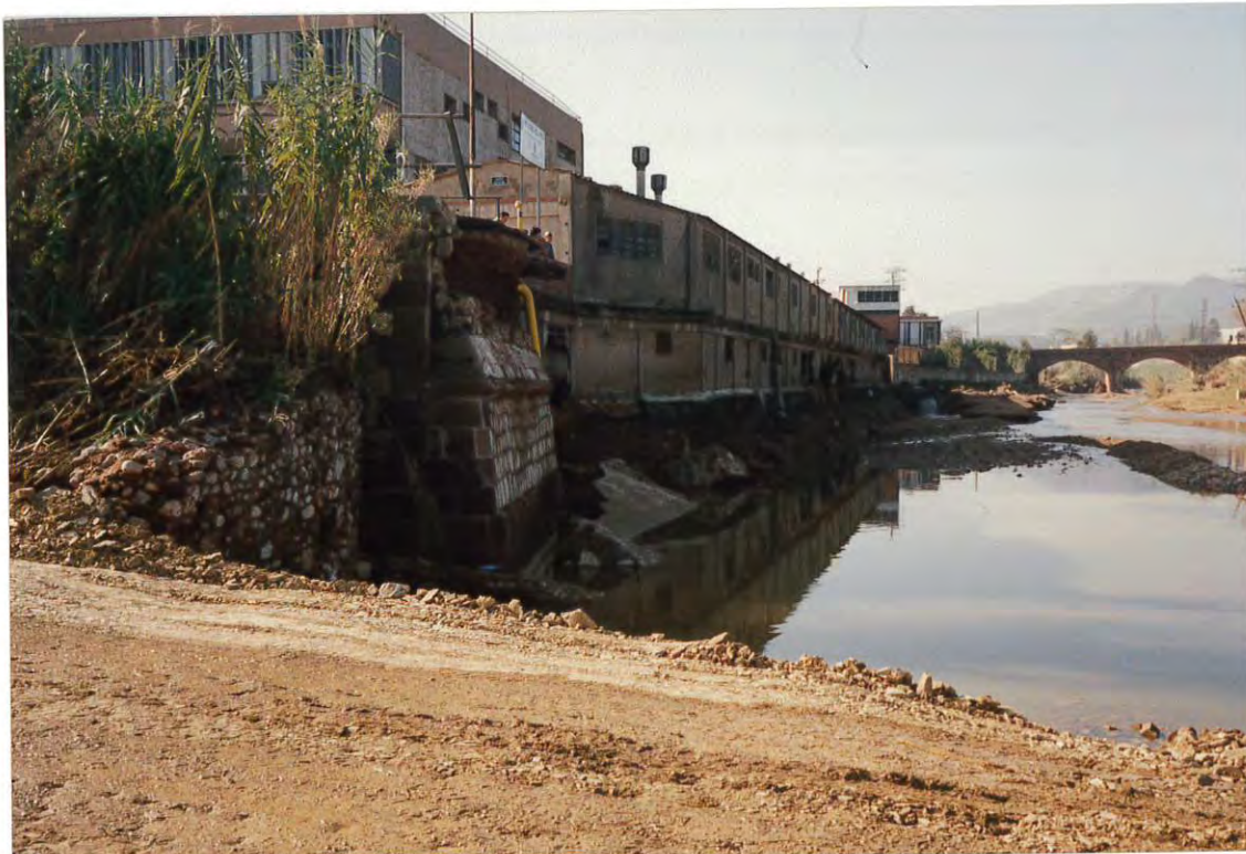
Figura 4. Estribo derecho del puente hundido, que aparentemente no sufrió desperfectos.
