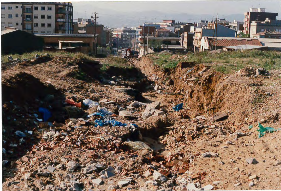
Figura 1. Cauce de la riera del Escorxador, aguas arriba de su entrada en el casco urbano, donde se aprecian los arrastres y la erosión producidos por el agua.
