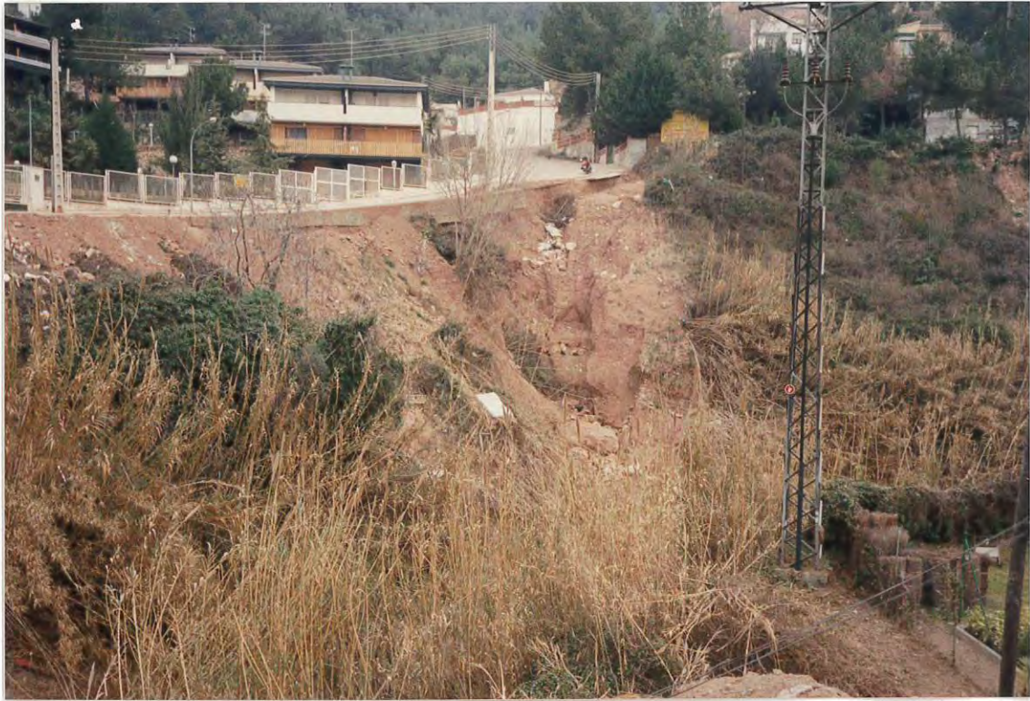
Figura 5. Altura del terraplén construido en el cauce de la riera, donde puede observarse la erosión producida por el agua al saltar sobre éste.
