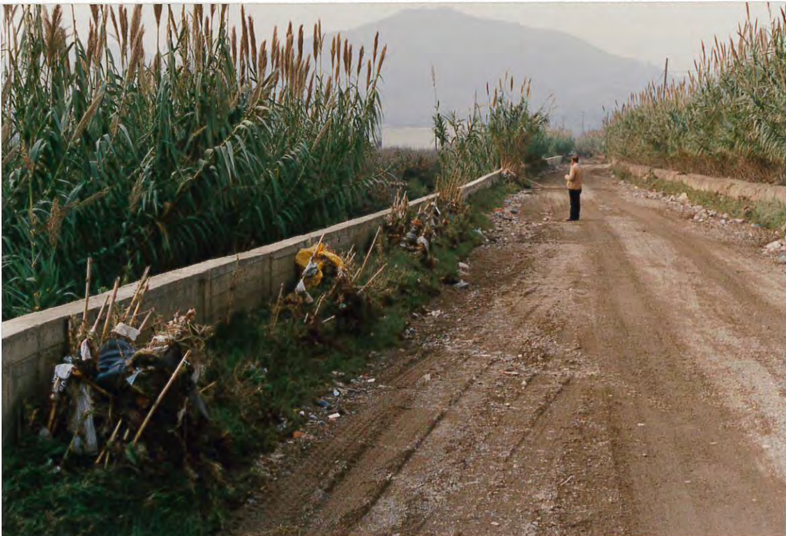
Figura 4. La altura donde quedaron depositados los arrastres permite asegurar que el agua sobrepasó los hastiales, inundando los campos colindantes.
