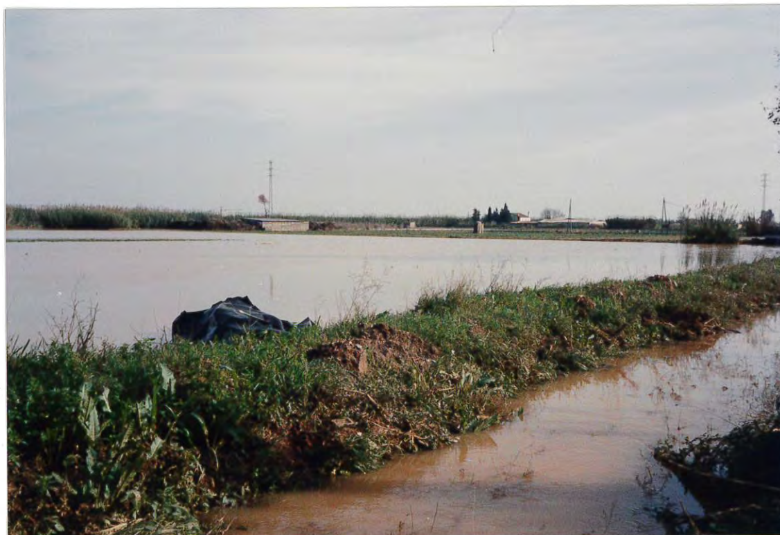
Figura 11. Campos inundados en las inmediaciones de la Autovía de Castelldefels.
