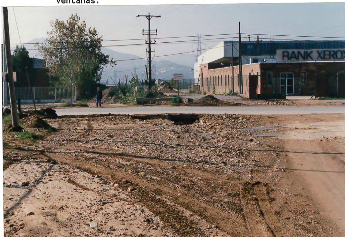
Figura 2. Arrastres acumulados en la Riera Infanta II, a su paso bajo la carretera N-II.
