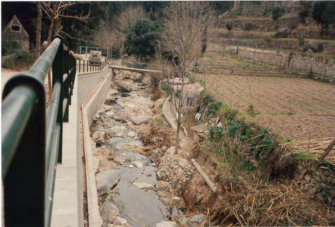
Figura 3. La disminución de la altura del muro provocó el desbordamiento de las aguas. Tubería totalmente descubierta por la erosión en la margen derecha.
