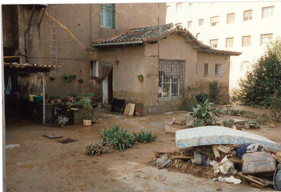
Figura 2. Vivienda fotografiada en 1983, 1987 y 1988. En los tres episodios de lluvia el agua alcanzó una altura aproximada superior a 1 m.
