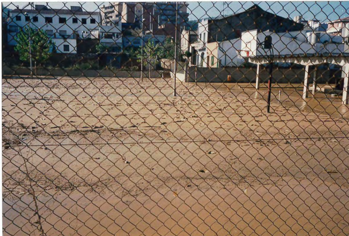
Figura 2. Patio de un colegio de Sant Vicenç dels Horts completamente cubierto de barro, en las inmediaciones de la carretera BV-2002.
