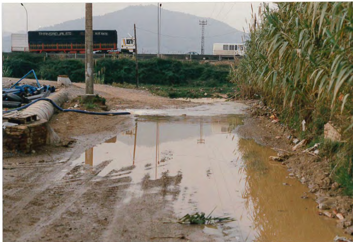
Figura 8. Tramo final de la riera la Salud, antes de desembocar en el canal de desagüe, donde puede apreciarse la contrapendiente final.
