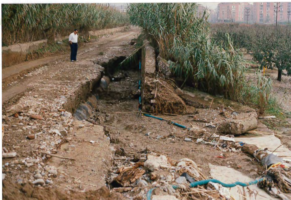
Figura 6. La colocación de servicios en el lecho de la riera impide realizar un correcto dragado y limpieza del mismo.
