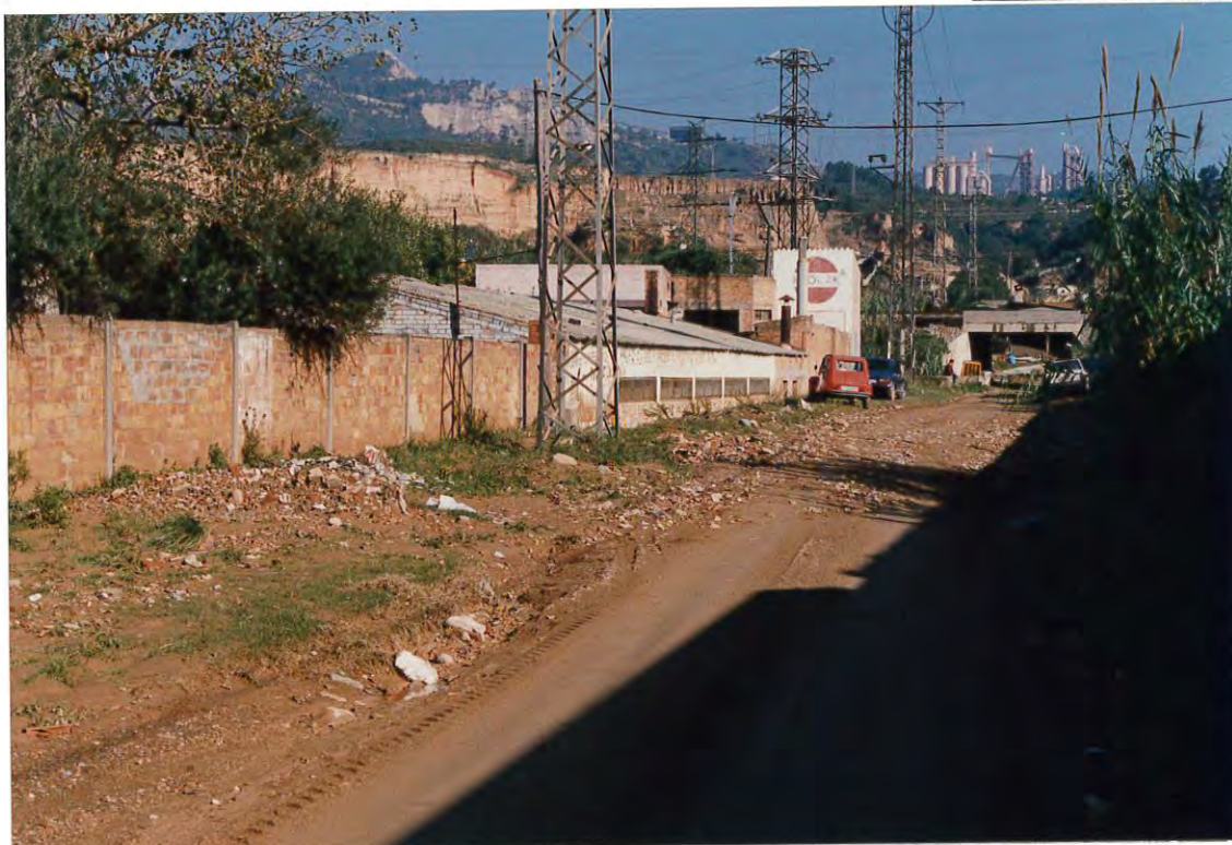
Figura 1. La Riera Infanta II, entre la del Terme y la de Can Sant Tomàs. El agua llegó hasta la parte inferior de las ventanas.
