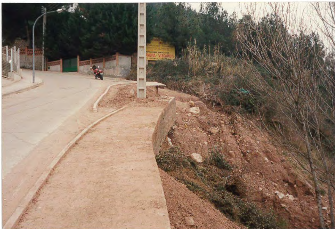
Figura 3. Cauce de la riera a su entrada en la urbanización. La fuerte pendiente hace que el agua circule a gran velocidad.
