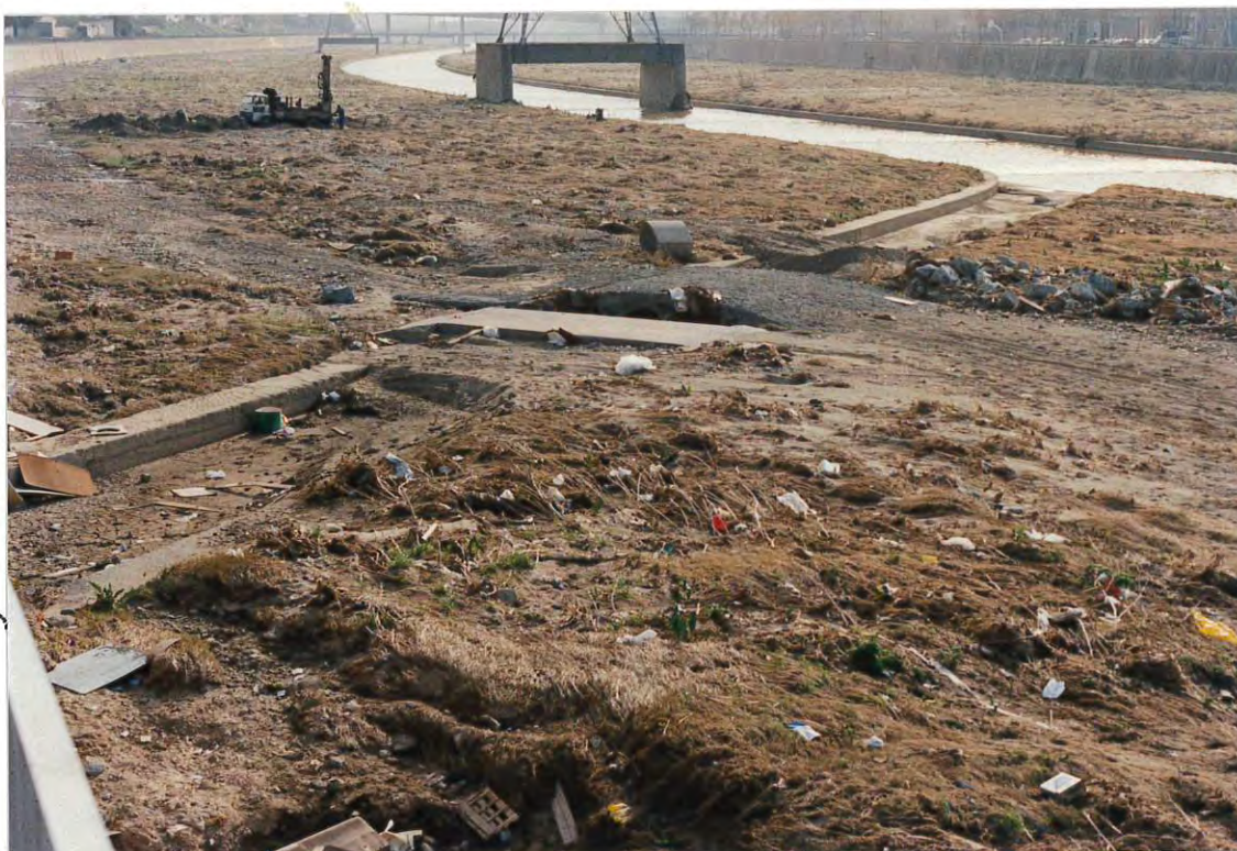
Figura 2. Desembocadura del Torrent Jané al río Besos, donde puede apreciarse la acumulación de arrastres provocada por los dos pontones.
