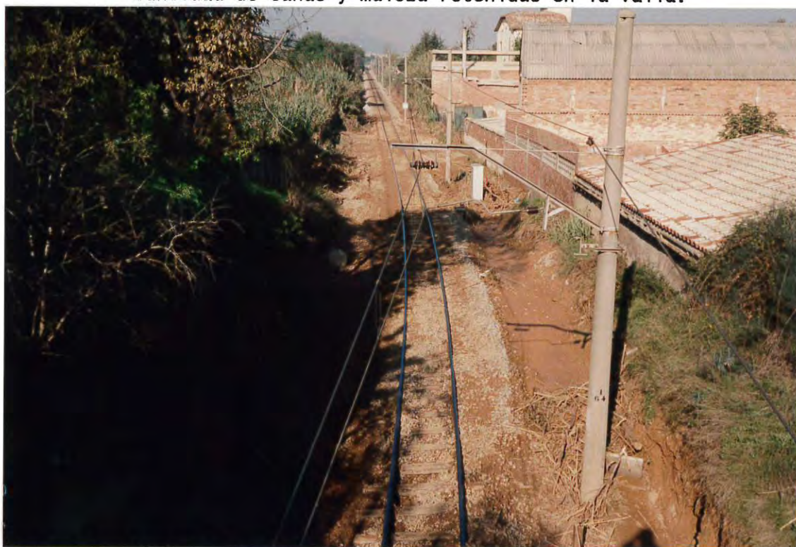
Figura 2. Vista general de la línea férrea Barcelona-Martorell, en los alrededores de la riera.
