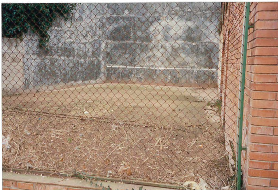
Figura 4. Patio de una finca que da directamente al cauce, donde puede observarse la altura alcanzada por los arrastres.
