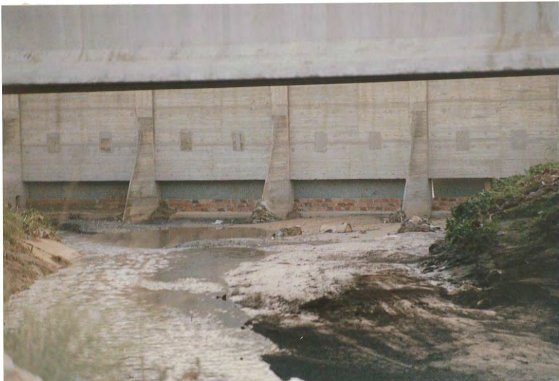
Figura 2. Recrecimiento de los aliviaderos de vertido al río.
