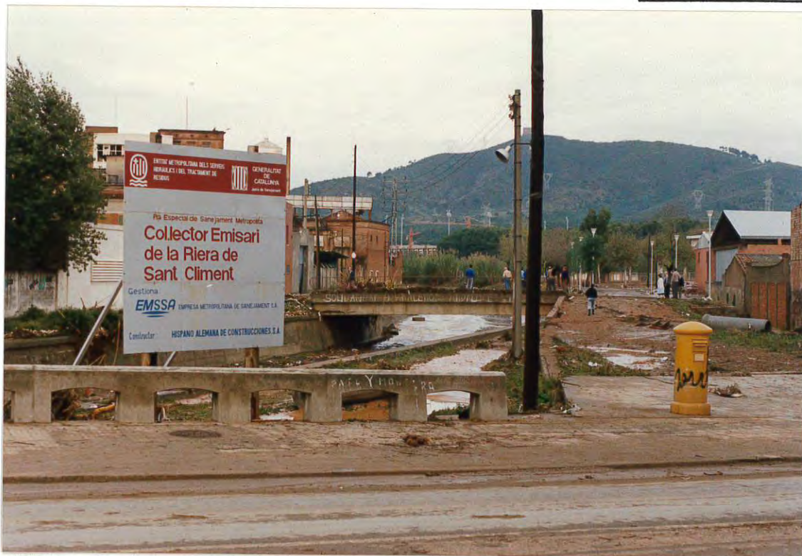
Figura 3. Barro acumulado en la carretera C-245, sobre el puente de la riera de Sant Climent.
