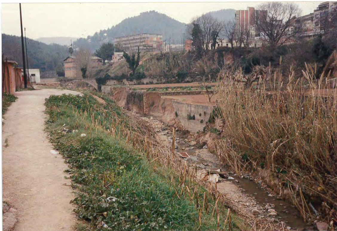
Figura 1. Vista general de la riera de Cervelló, en el tramo donde se produjeron inundaciones.
