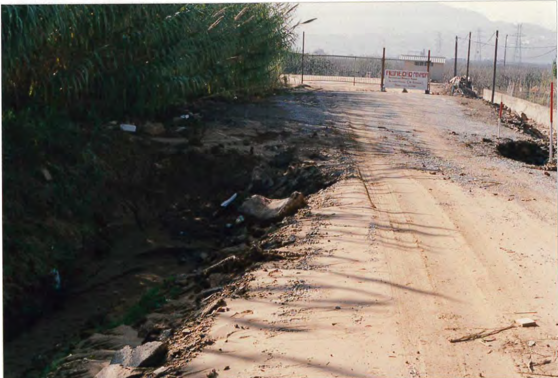
Figura 4. El cauce natural de la riera ha sido cortado por un propietario agrícola a fin de unificar sus terrenos. El cauce alternativo bajo el camino es un tubo de 50 cm.
