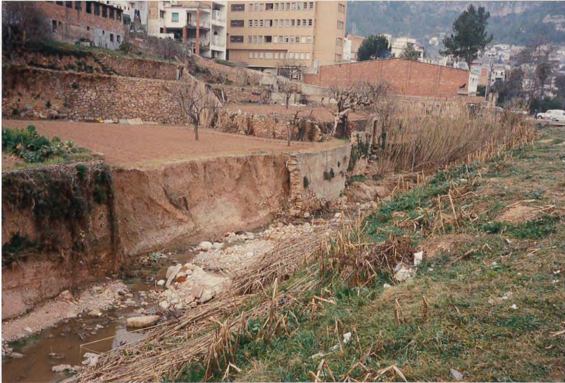
Figura 3. Muro destruido por las aguas en la margen izquierda de la riera de Cervelló.
