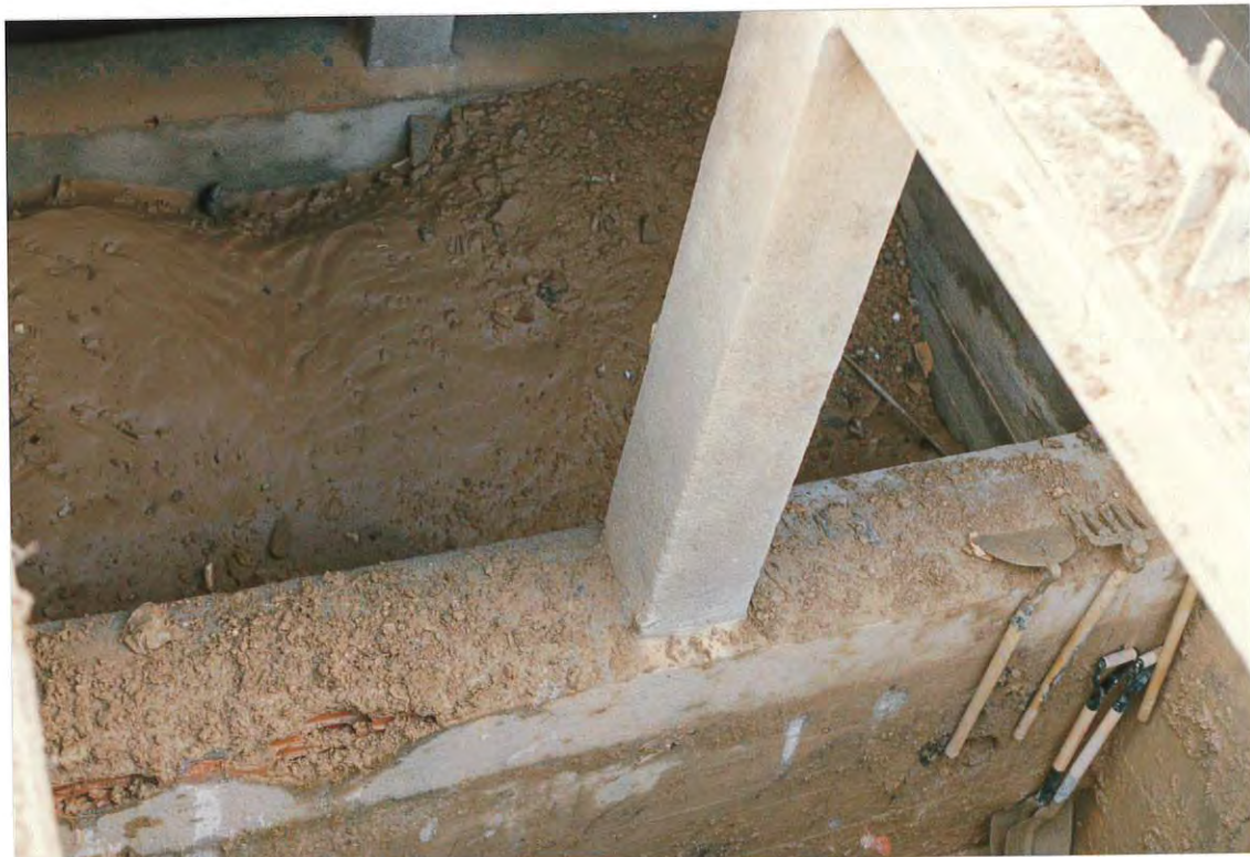
Figura 4. Arrastres acumulados en el dispositivo de retención de sólidos ubicado en la embocadura de la canalización de la riera del Escorxador.
