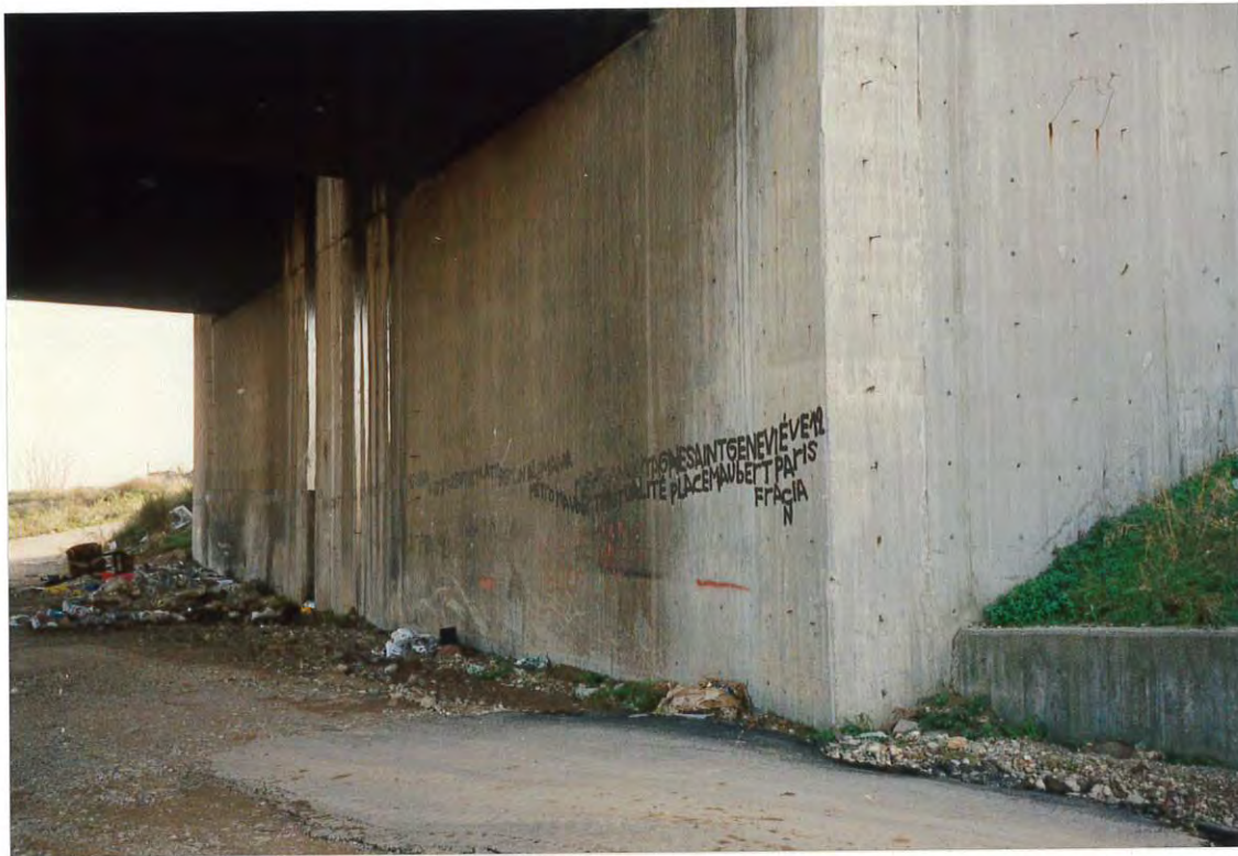
Figura 5. Estribo derecho del puente de la carretera nacional N-II sobre el río Llobregat, donde las aguas no llegaron a sobrepasar su base. Las marcas rojas son de 1982 y 1983.
