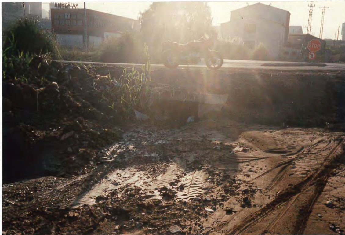
Figura 1. Salida de la riera aguas abajo de la carretera nacional N-II. La limpieza efectuada impidió su inundación.
