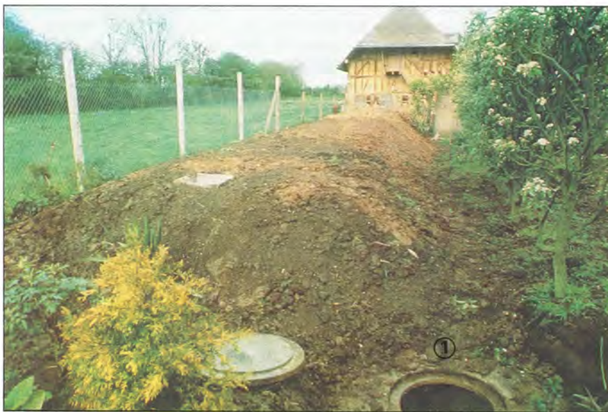
① Fosse pour la pompe de relèvement. ② Alimentation électrique.
