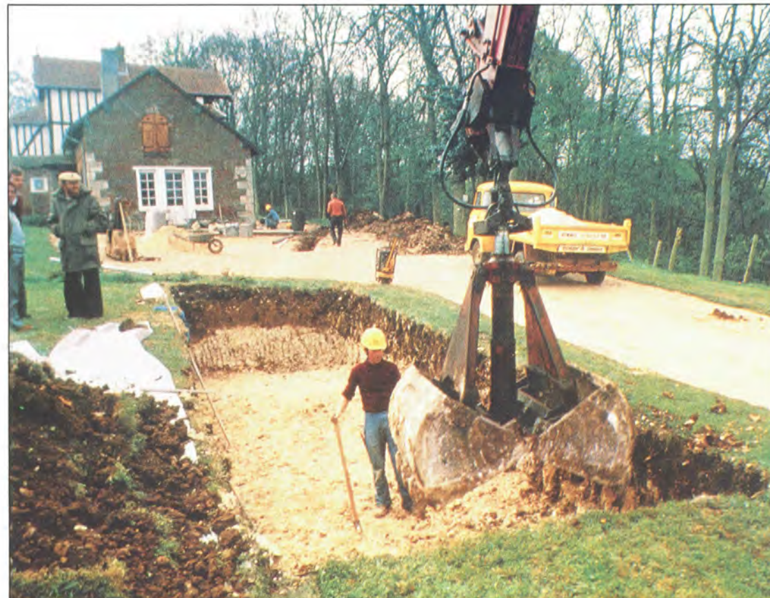
Filtre à sable, excavation avant remplissage par le sable et les graviers
