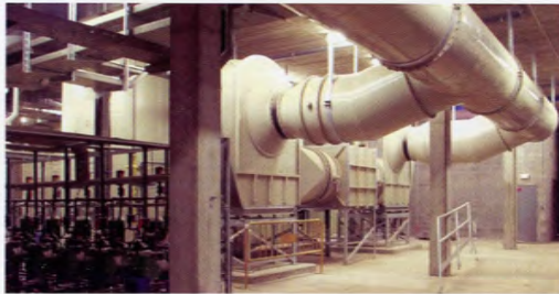
Instalaciones de desodorización del tratamiento primario
