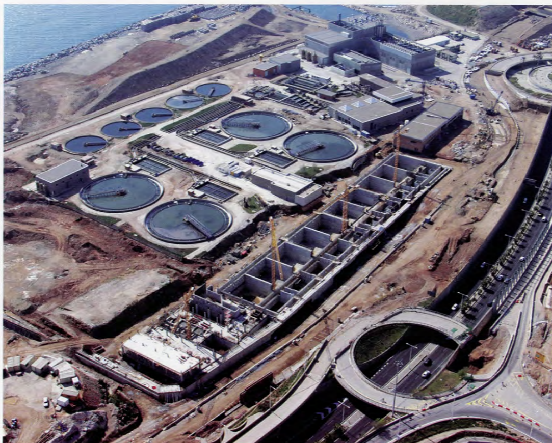
Vista general de las obras durante su ejecución
