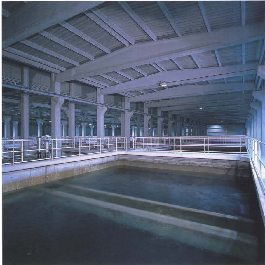
Detalle de un filtro de carbón activo
