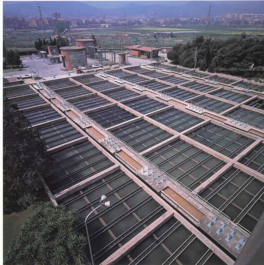
Vista general de los sedimentadores
