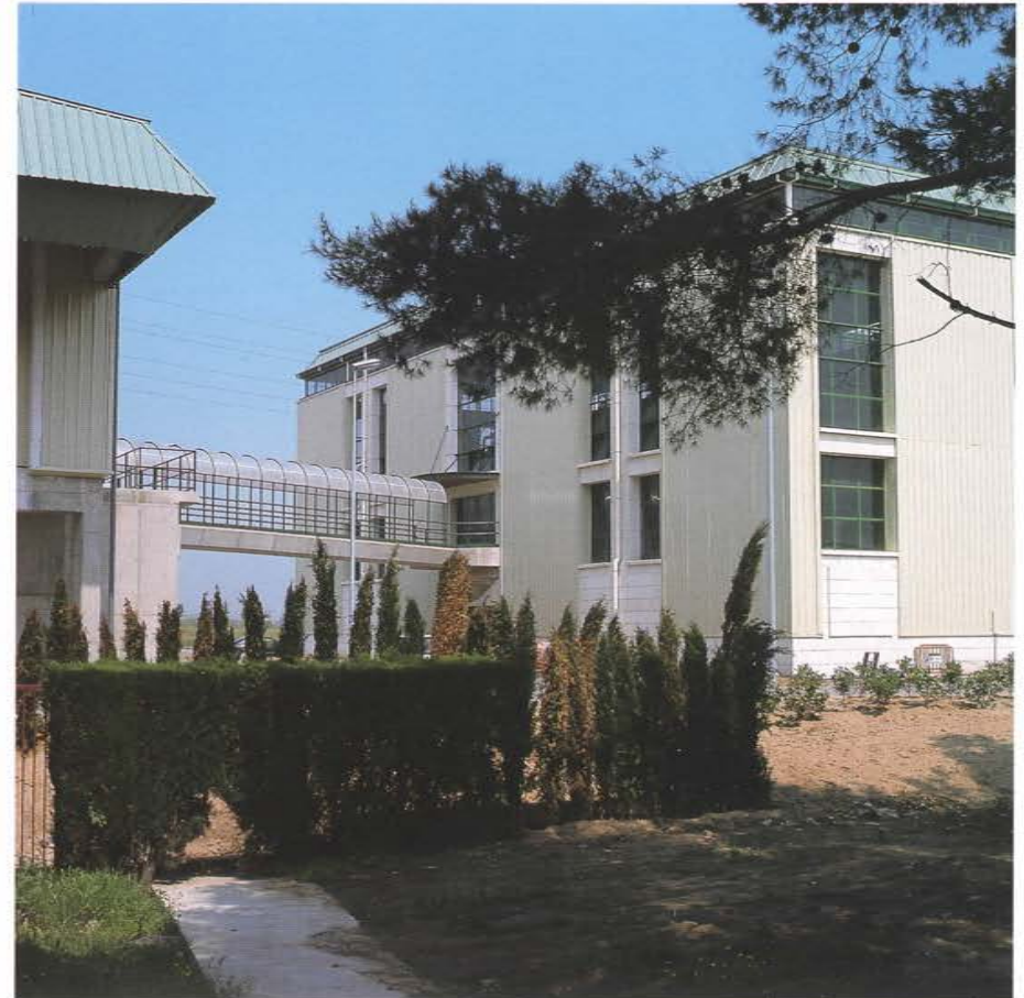
Vista exterior del edificio de ozonización
