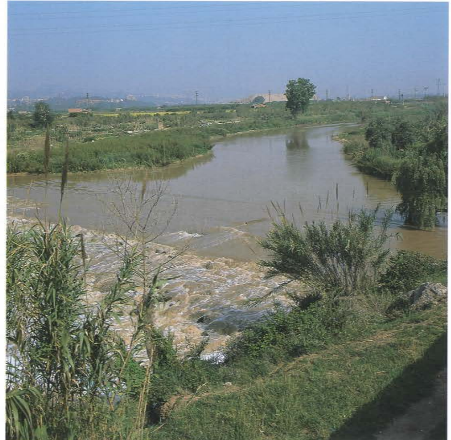
Captación en el río Llobregat
