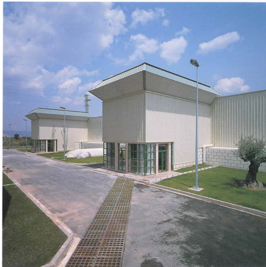
Vista exterior del edificio de filtros de carbón activo
