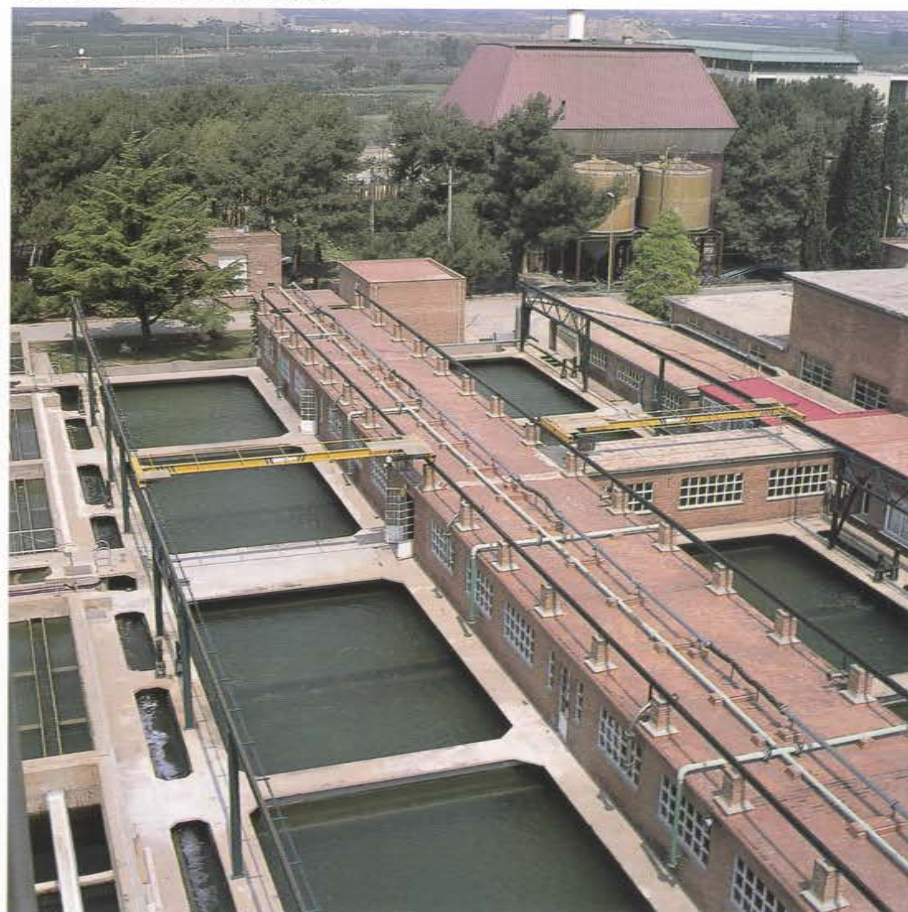
Vista aérea de los filtros de arena
