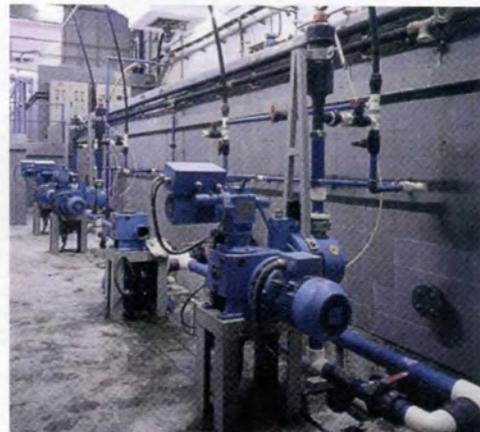
Instalación para dosificar sulfato de aluminio
