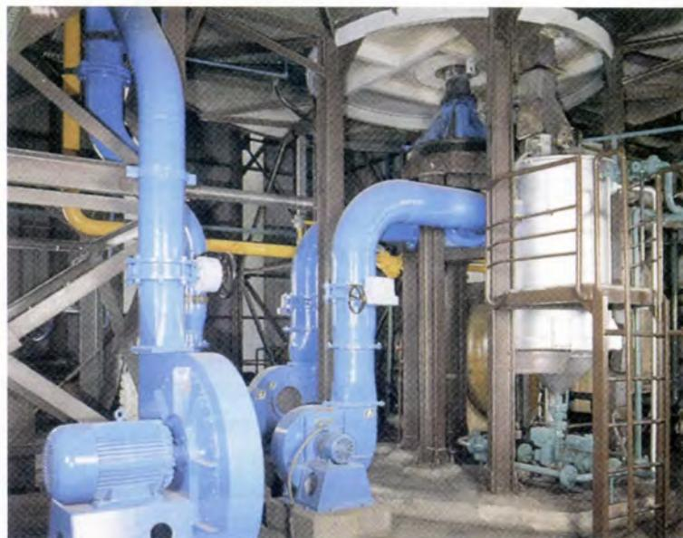
Detalle de los ventiladores de aire de combustión y de refrigeración del eje
