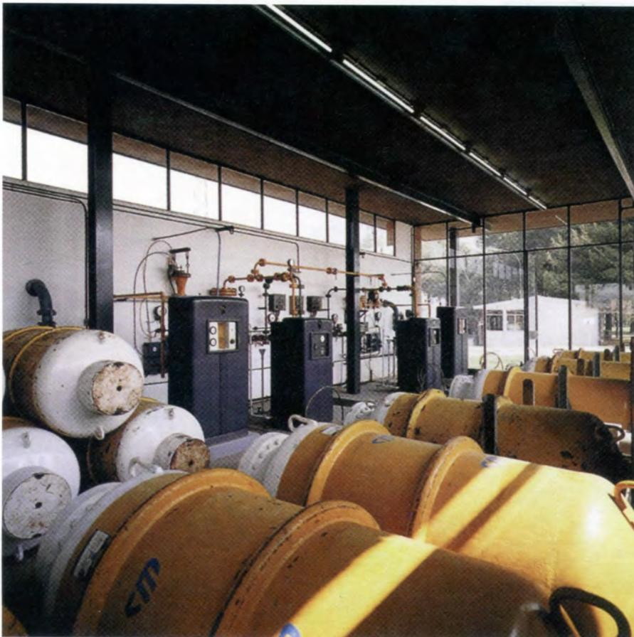
Instalación para dosificar el cloro y los evaporadores
