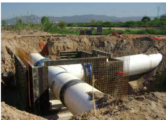
Canonada per a la reutilització d'aigua al Baix Llobregat
