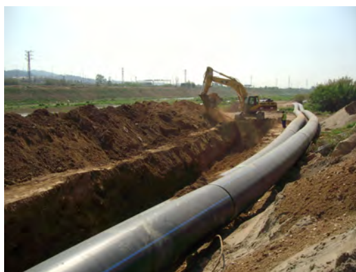
Canonada per a la reutilització d'aigua al Baix Llobregat
