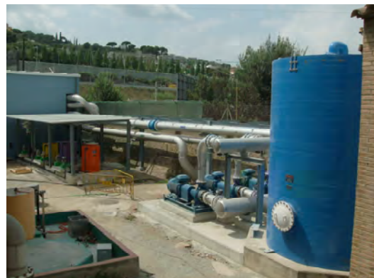
Ultrafiltració de la planta del Besòs per a la recuperació del Rec Comtal
