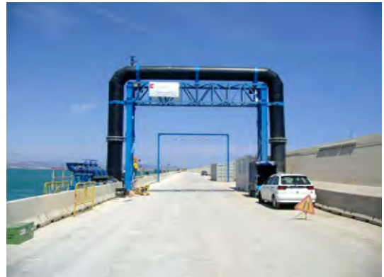
Conducció des del Port de Barcelona fins a l'EDAR del Baix Llobregat
