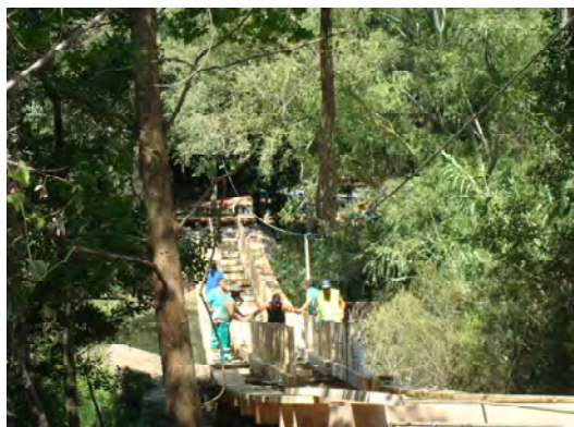
Passarel·la sobre La Muga per a l'abastament de Figueres
