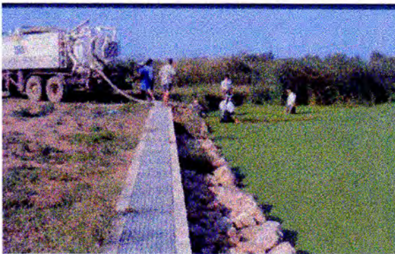
Figura 9. Feines d'extracció de lemnes en una de les cel·les del sistema d'aiguamolls construïts d'Empuriabrava. Agost de 1999.
