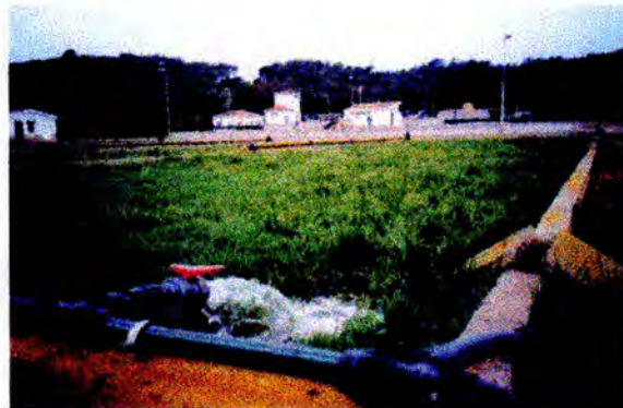
Figura 5. Vista de les eres d'assecatge de l'EDAR de Tossa de Mar, rehabilitades per al tractament addicional de l'aigua depurada.
