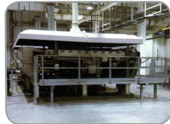
مشغلات الحمأة Gravity Belt Thickeners
