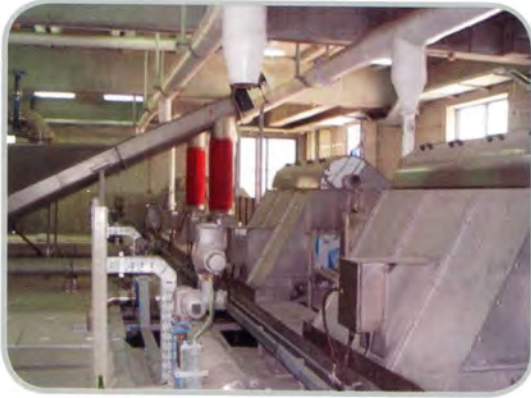
مبنى إزالة المواد الصلبة العالقة Screening Building
